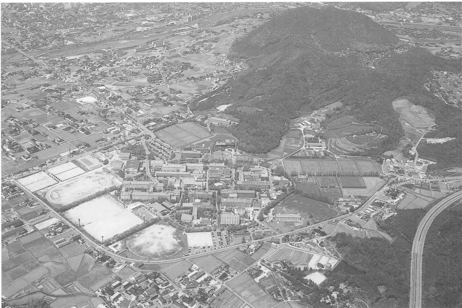
吉田構内全景（南から）
