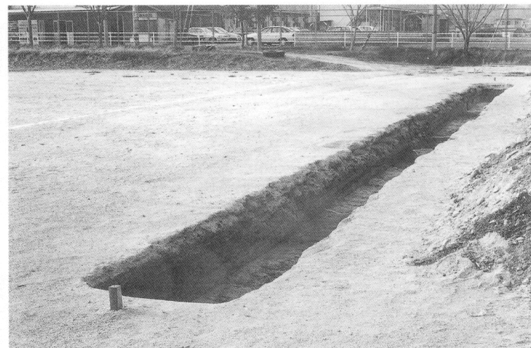
(4) 配線トレンチG区(北から)
