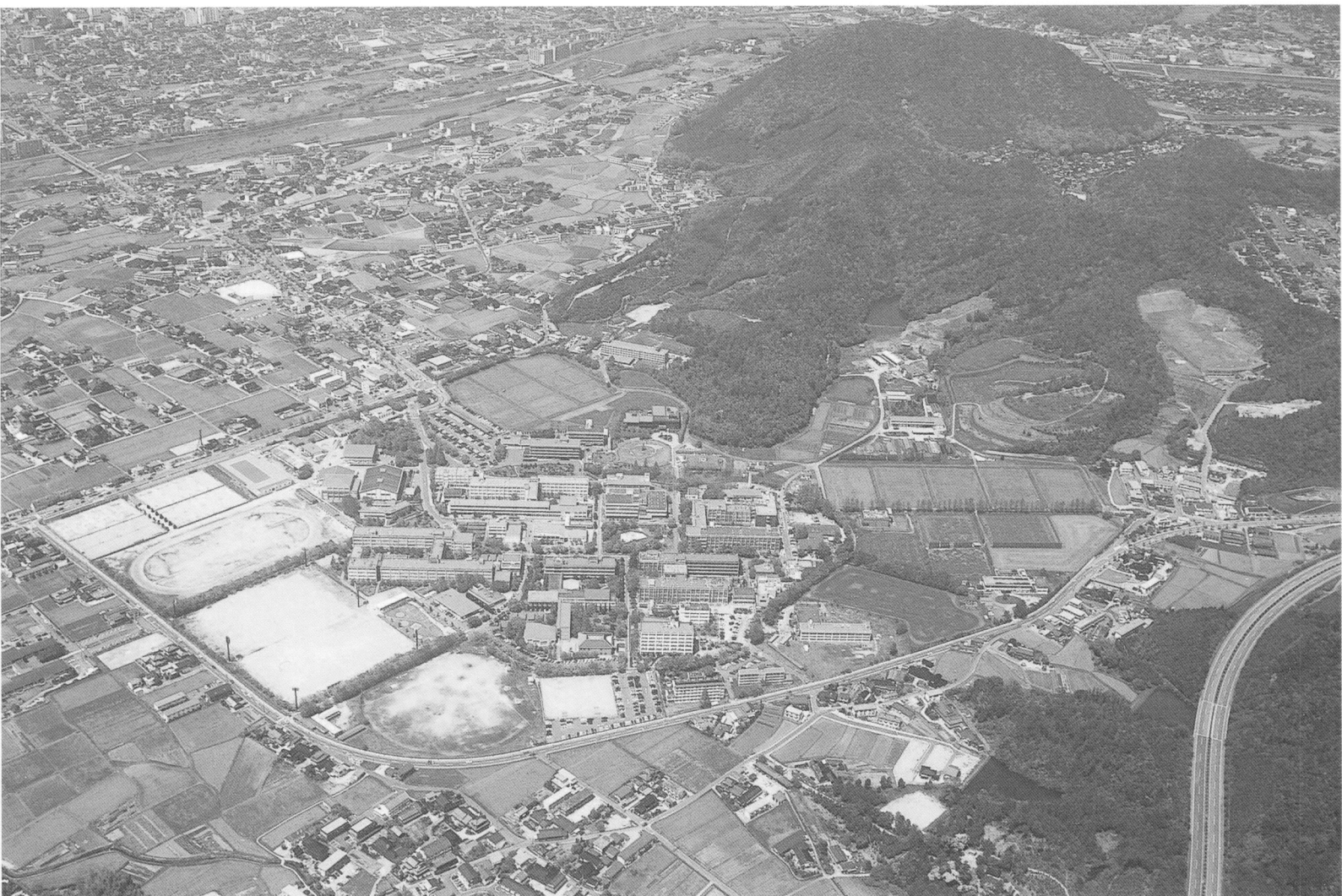
吉田構内全景（南から）
