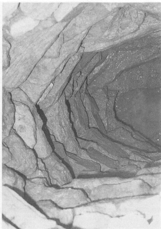
(3) 第1号井戸石組状況(北西から)
