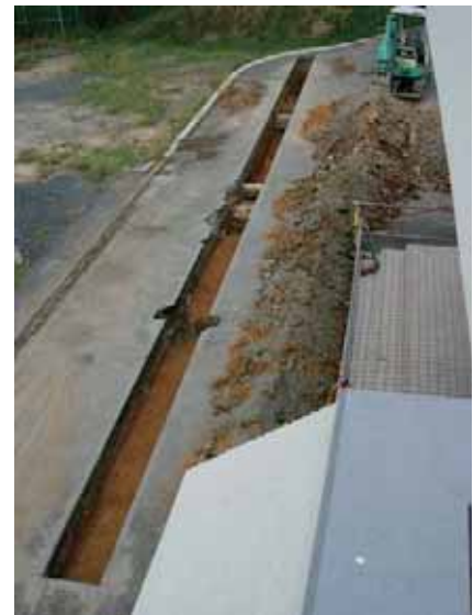
写真 46 A区全景 (南から)
