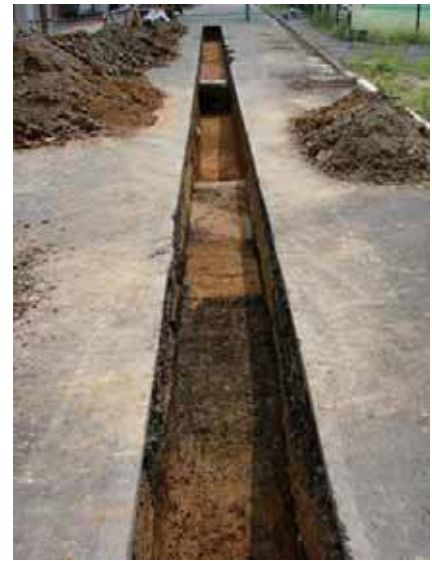
写真 45 A区全景 (北東から)
