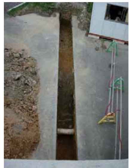
写真 47 B区全景 (南西から)
