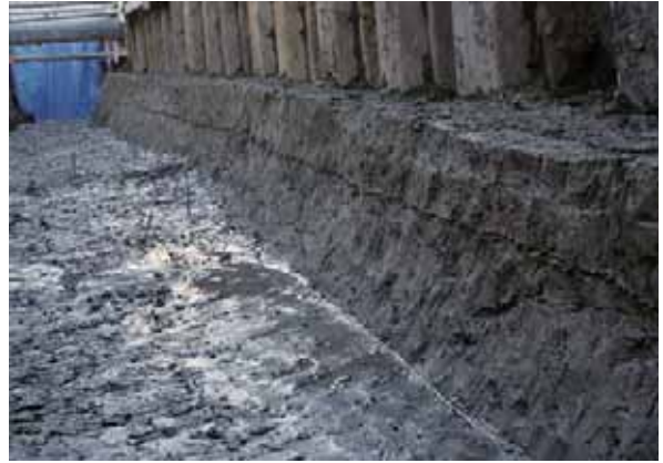
写真23 第2調査区土層断面㊦(北東から)
