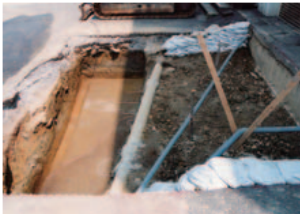
写真13 D調査区全景 (西から)
