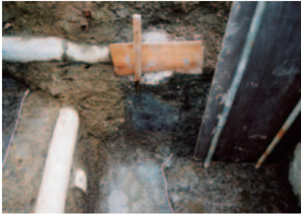
写真31 C調査区西壁土層断面(東から)
