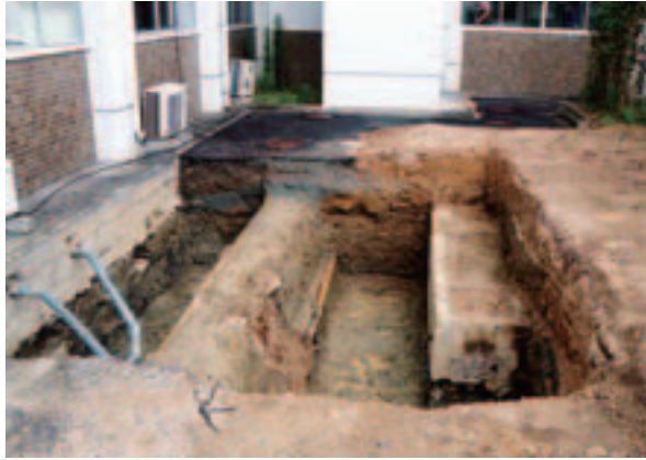
写真9 A調査区全景 (西から)
