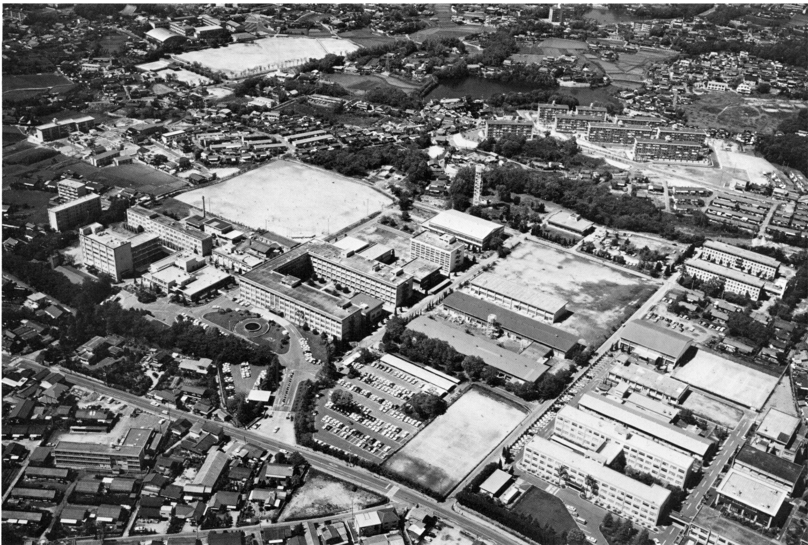
常盤構内（工学部・工業短期大学部キャンパス）全景（南から）
