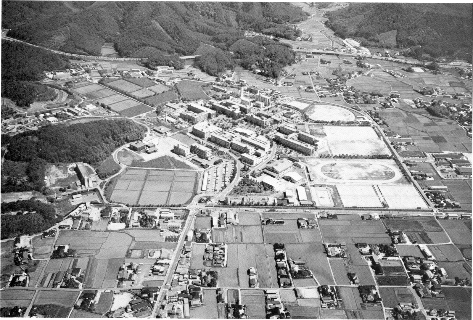
吉田構内全景（北西から）
