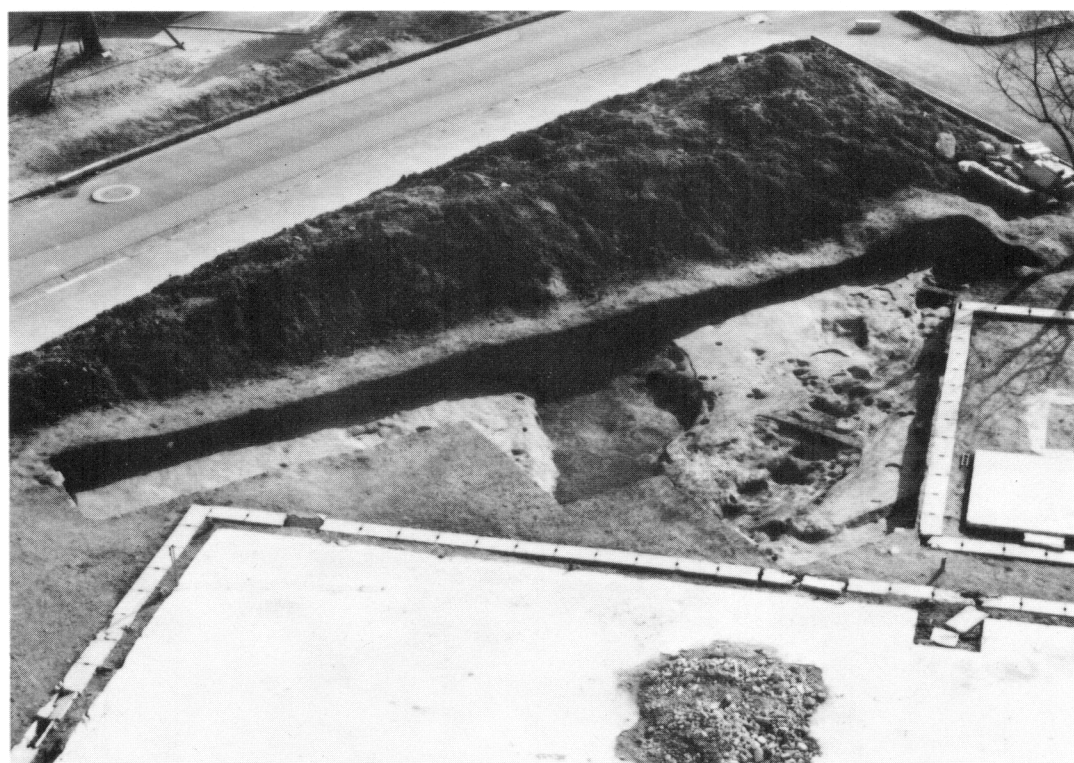
(2) A地点全景（北東から）
