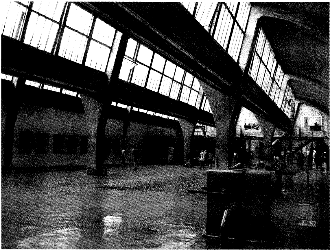
図10 北向きの窓からは安定した光線が入る。
