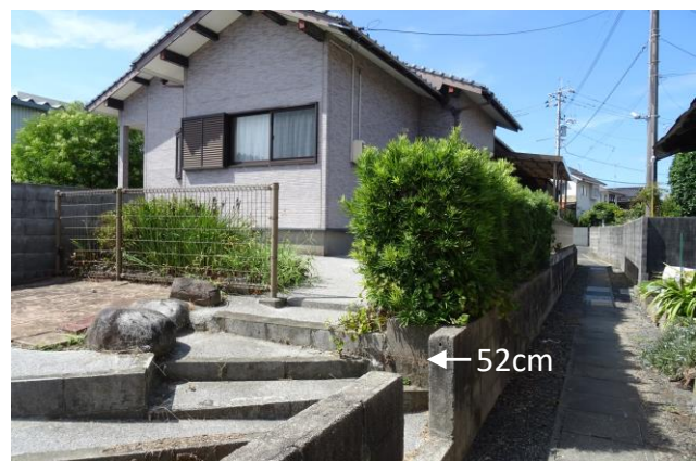
写真 2.3 宅地の入口階段における浸水痕跡
