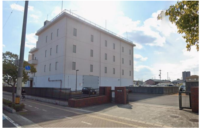
写真 2.1 小串ポンプ場
