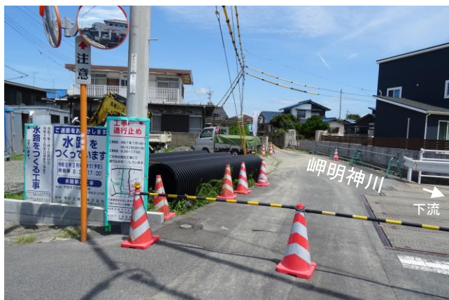
写真 5.3 五十目山雨水幹線工事
