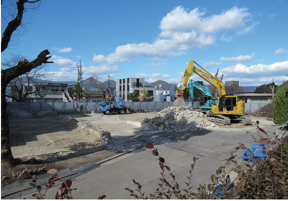
写真 37 特殊排水処理施設・排水管理棟 解体状況 (南から)
