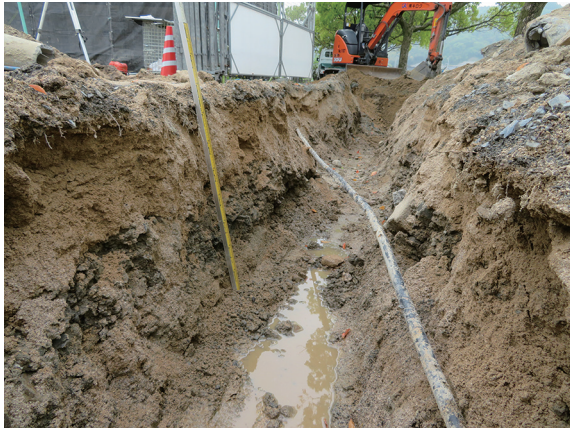
写真45 C区土層断面(北西から)
