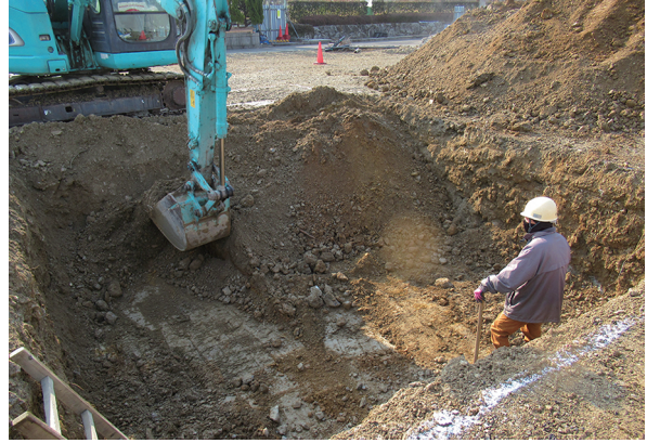
写真 38 重機掘削風景 (北から)
