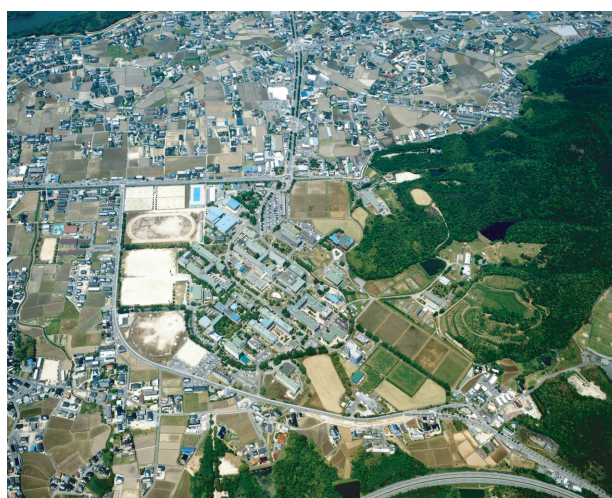
写真20 吉田構内航空写真(南東から)
