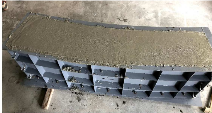
a) 打設状況
