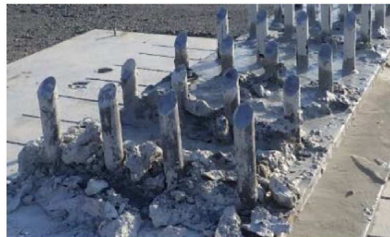
(d) RC 床版撤去後のスタッドジベル
