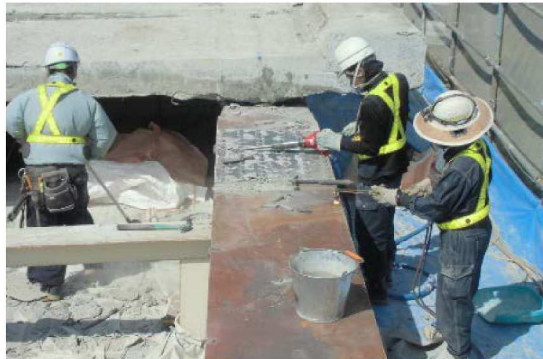
図-1.1.33 撤去後の鋼桁上フランジのケレン
