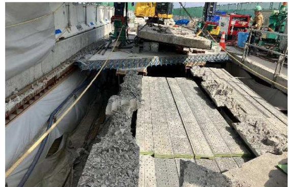
図-4.5.9 床版撤去後の鋼桁上フランジの状況
