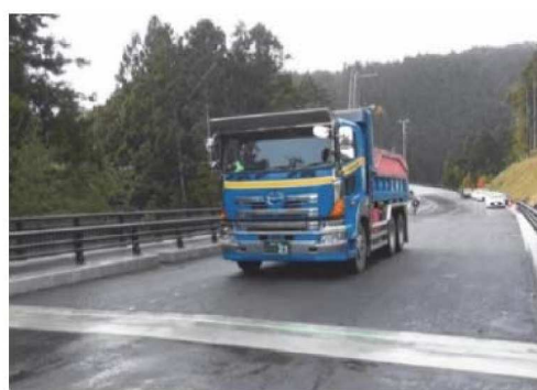
図-5.4.5 動的載荷状況（トラック走行）
