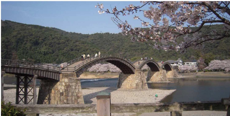
図-1.1.1 岩国錦帯橋（木造5連アーチ橋）
