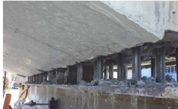
(b) 撤去した RC 床版供試体
