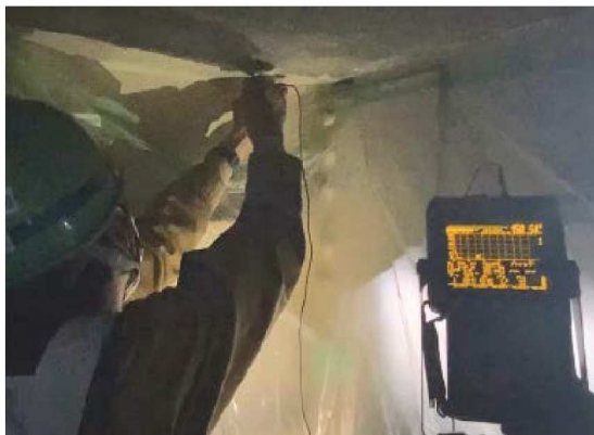
図-4.4.4 超音波探傷器による切断確認
