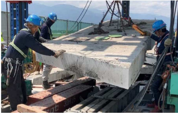
図-4.5.8 開発技術により撤去した RC 床版ブロック
