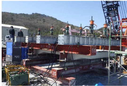
(a) RC 床版供試体のジャッキアップ状況
