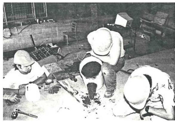
図-3.5.12 PC 版下へのモルタル充填
