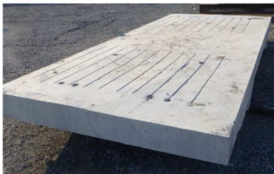
(c) 撤去した RC 床版供試体
