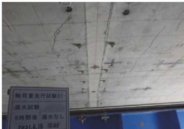
図-5.2.12 漏水試験状況（E1, 6時間後）
