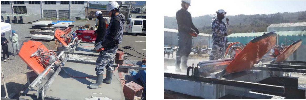
図-4.4.6 ウォールソーによるスタッドジベル切断状況
