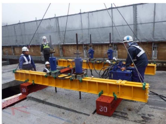
図-1.1.32 既設RC床版のジャッキアップ
