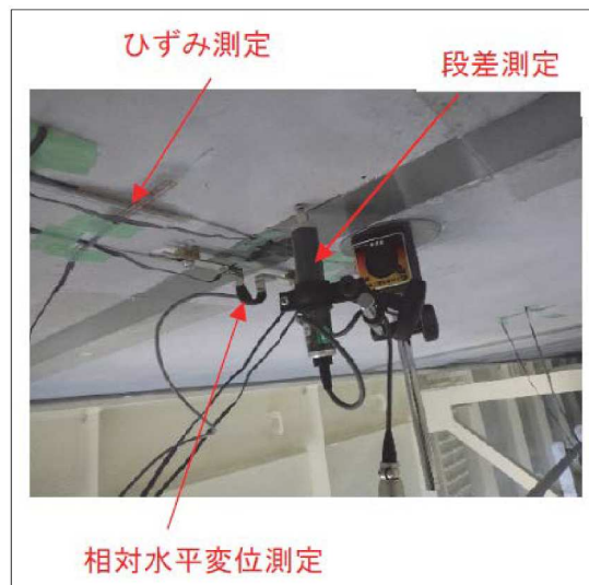
図-5.4.7 床版下面計測状況
