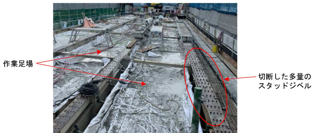
図-1.2.3 鋼合成桁橋床版の撤去後の状況
