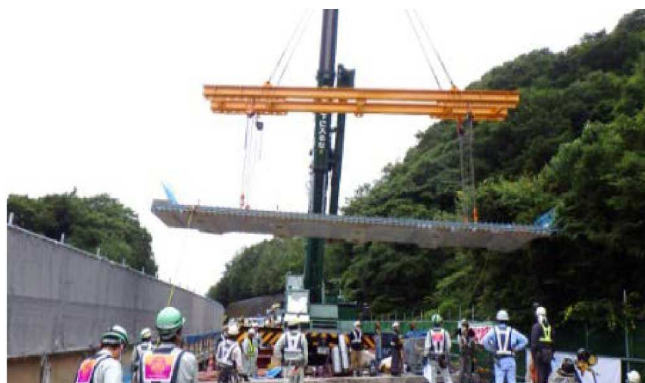
図-1.1.35 プレキャストPC版架設状況
