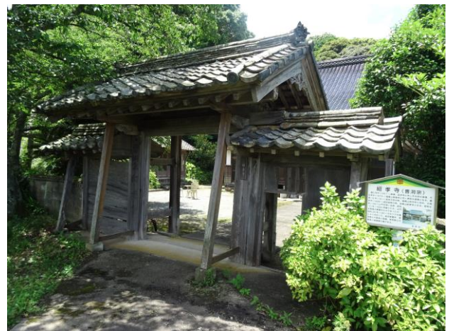
写真 1 昭和 26（1951）年のルース台風に伴う豪雨による山門流失の記録（説明の看板にはキジア台風と誤記されている）
