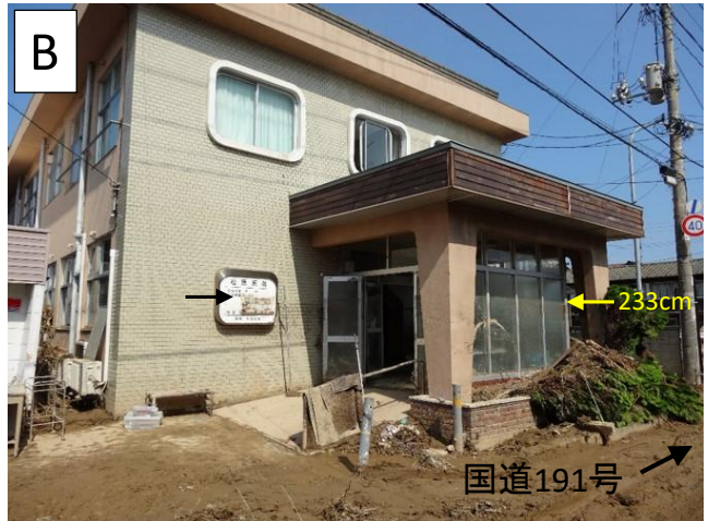
写真 6.B 医院の浸水被害(2013年7月31日撮影)
