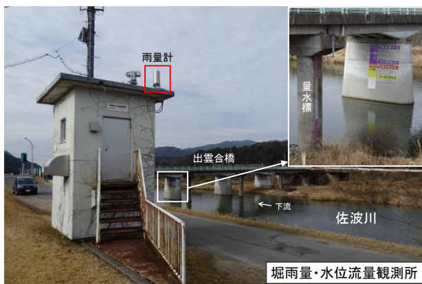
写真3 徳地の堀雨量・水位流量観測所（国土交通省中国地方整備局山口河川国道事務所の所管）
