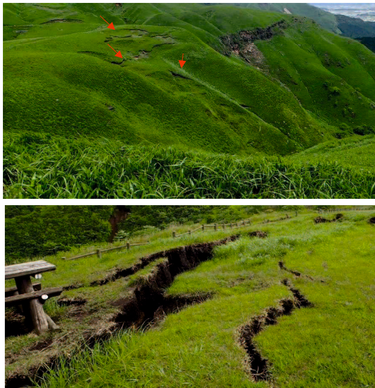
写真 2.5-1 熊本地震時に発生した亀裂
