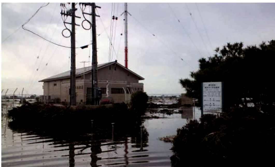
図1.1 津波による被害を受けた東北放送 荒井ラジオ送信所 1)
