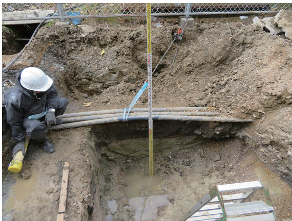
写真 43 C地点土層断面（東から）
