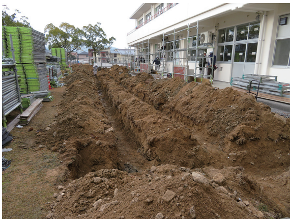
写真78 A区調査地近景(北東から)
