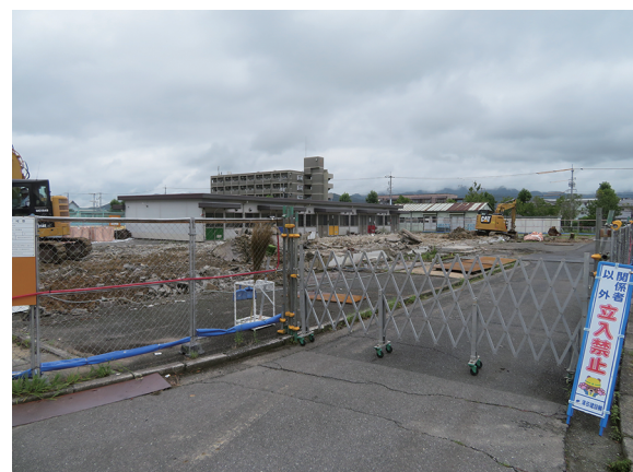
写真 29 既設文化サークル棟A解体(西から)
