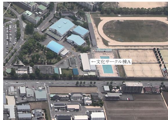
写真 28 調査前遠景(北西上空から)
