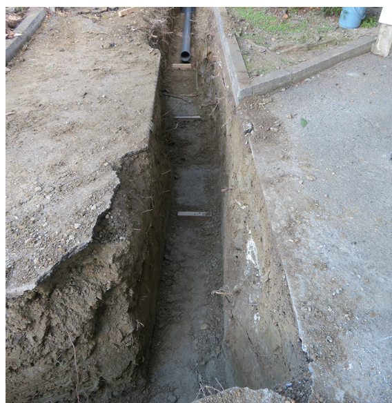
写真 72 調査区全景(南西から)
