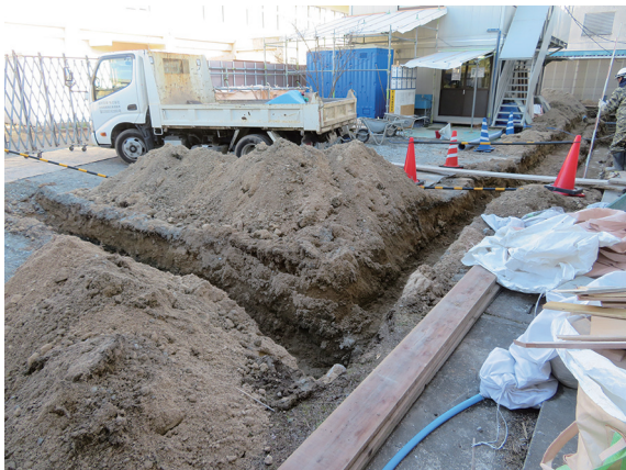
写真80 B区調査地近景(北東から)
