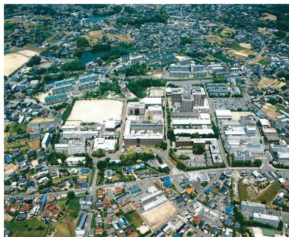
写真26 常盤構内航空写真（南から）
