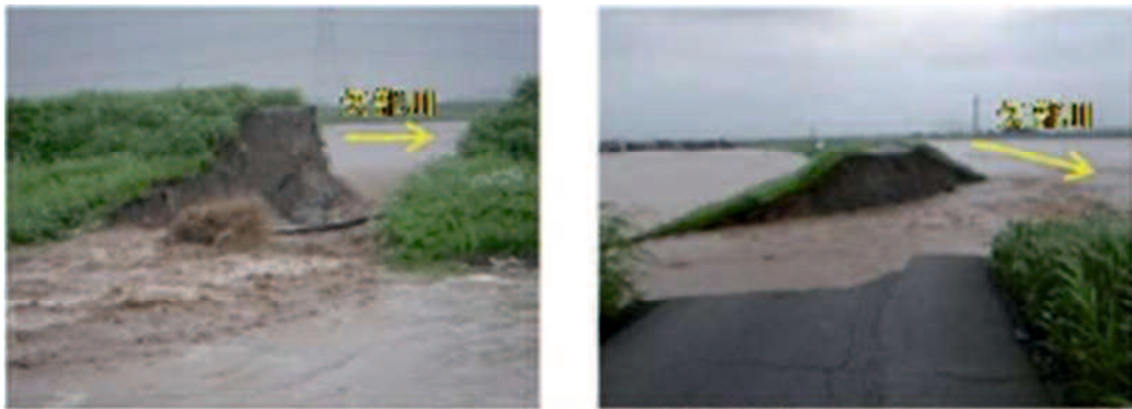
図2.2.2 7k300における矢部川堤防決壊状況 4)
