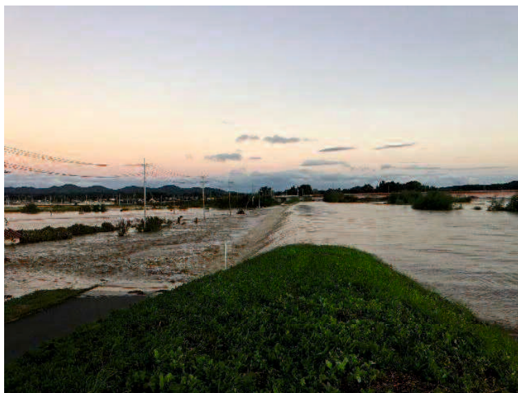
写真 3.1.1 越水による決壊の事例 2)
