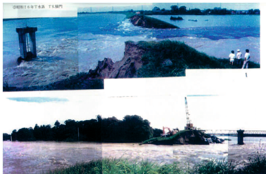
図 3.1.5 樋管周りの被災の事例
