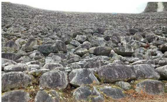
(a) D ダム（ダム下流端から上流側を撮影）
