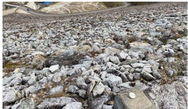
(b) E ダム（ダム天端から下流側を撮影）
