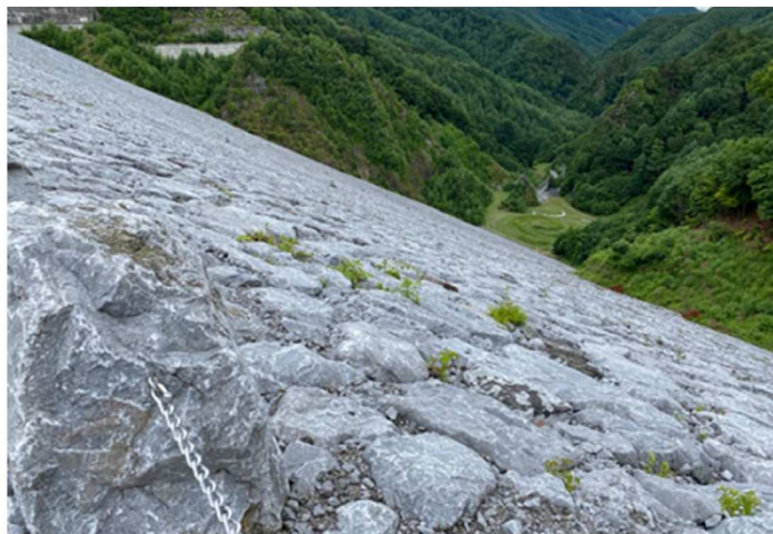
図-2.1 ロックフィルダムの表面
