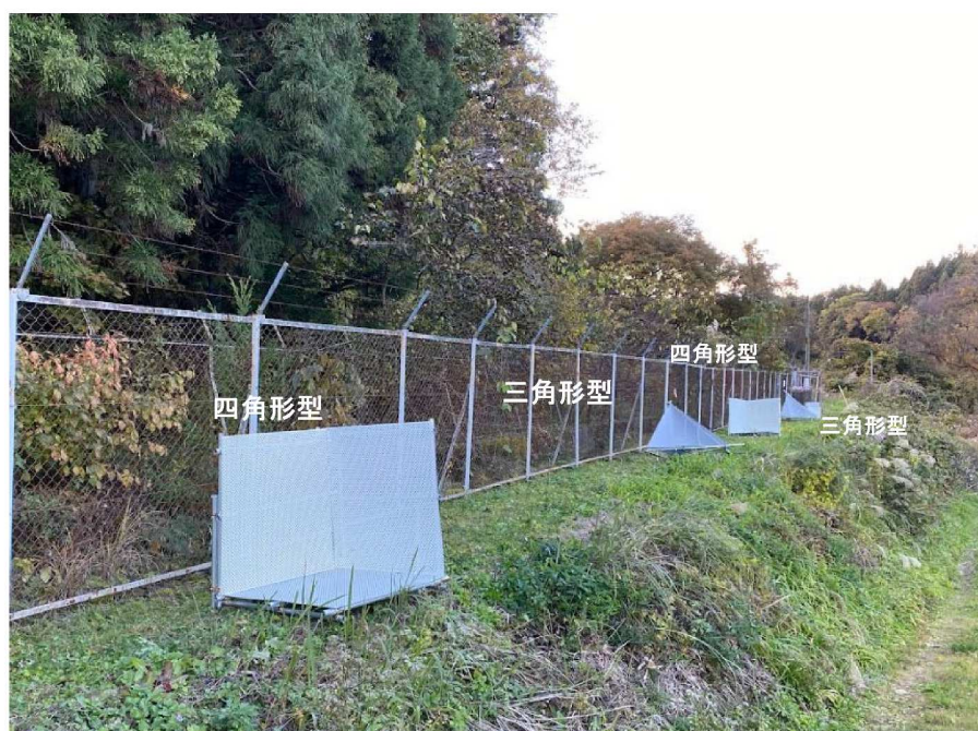
図-5.3 コーナーリフレクタの設置状況
