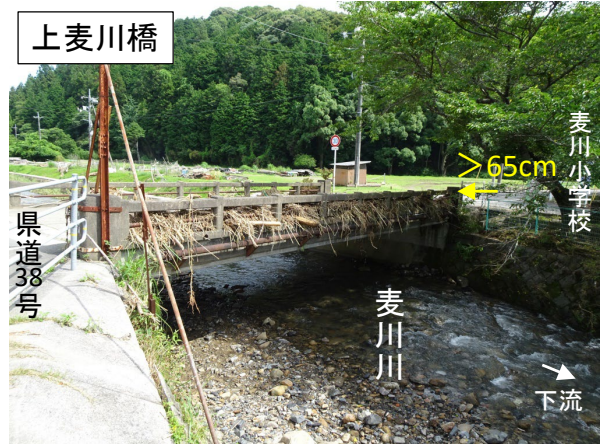
写真 2.4 上麦川橋における浸水の痕跡 (地盤からの高さ、cm)
