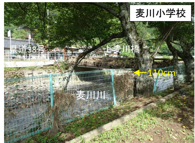
写真 2.5 麦川小学校の麦川川に面したフェンスにおける塵芥の付着(地盤からの高さ 110cm)
