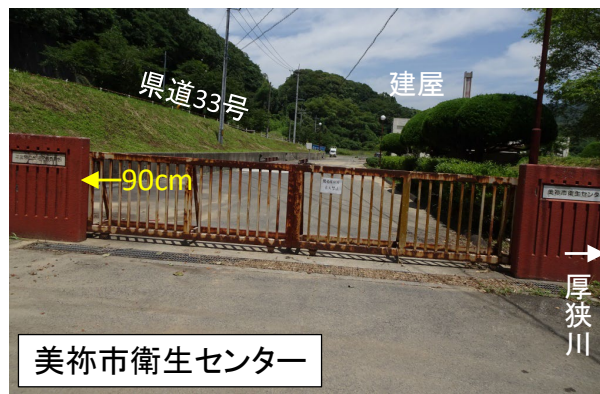
写真 4.7 美祢市衛生センターにおける浸水の痕跡
