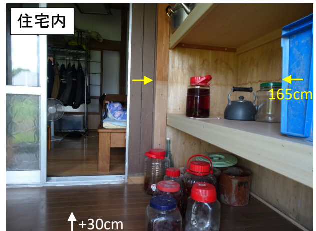
写真 5.11 写真 5.10 の住宅内における浸水の痕跡 (地盤からの高さ、cm)
