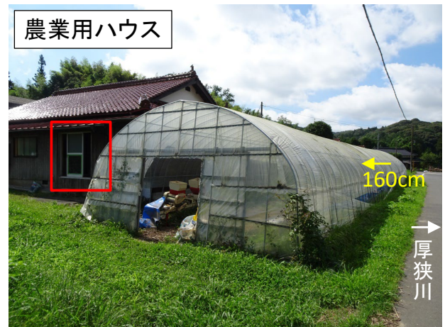
写真 5.10 農業ハウスにおける浸水の痕跡 (地盤からの高さ、cm) (赤枠内は写真 4.12)
