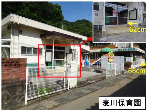
写真 2.2 麦川保育園における浸水の痕跡 (地盤からの高さ、cm)
