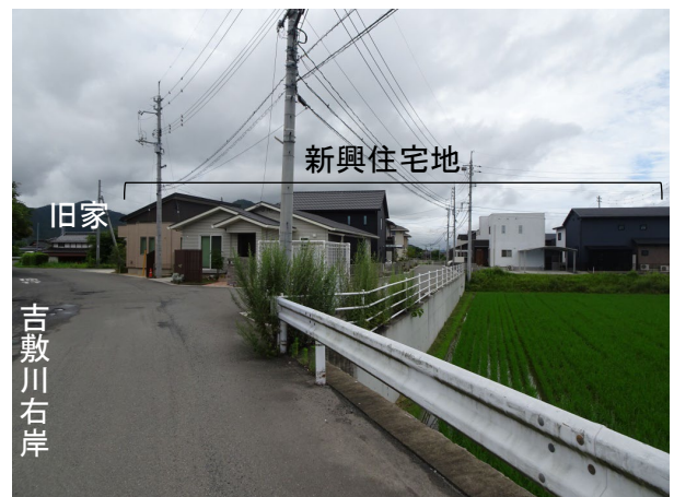
写真 2.18 吉敷川の大歳橋下流右岸において 開発された新しい住宅地 (3日撮影)
