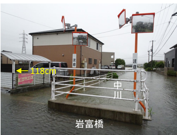
写真 2.6 岩富橋付近における浸水の状況（1日7時47分撮影、岩富地区）
