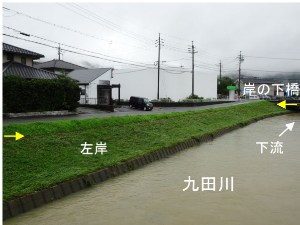
写真 1.1 岸の下橋上流左岸における九田川の水位と塵芥の状況（1日11時01分撮影）
