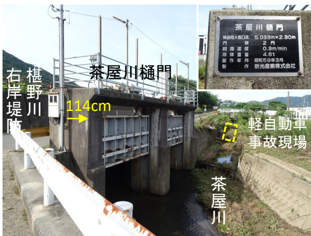
写真4.2 茶屋川樋門と軽自動車の事故現場
