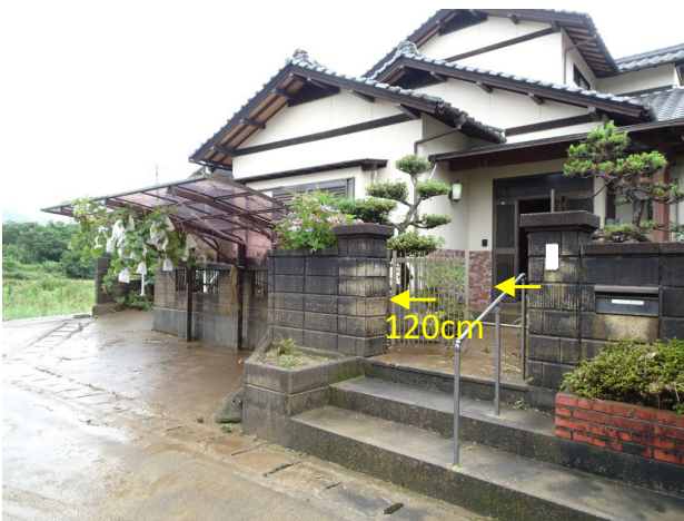
写真 2.15 鴨原における住宅の浸水状況 (1日 12時 31分撮影)
