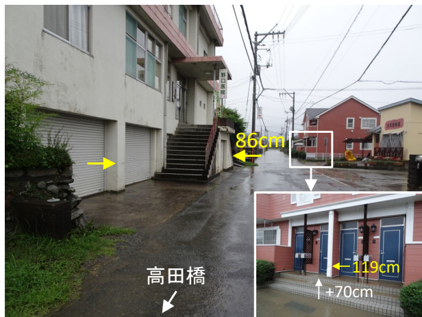
写真 2.5 岩富に位置する医院と集合住宅における浸水の状況 (1日 7時 30分撮影)
