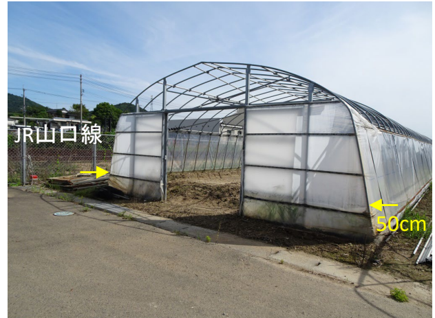
写真 4.7 農業ハウスにおける浸水痕跡
