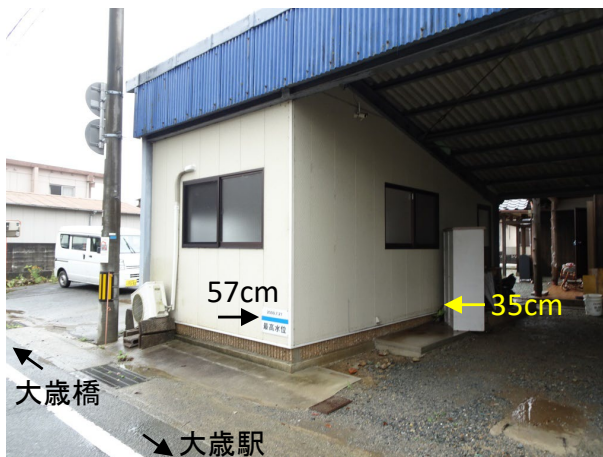
写真 2.13 岩富に設けられた 2009 年水害時の浸水実績標（57cm）と今回の浸水深（1日 12時 04分撮影）
