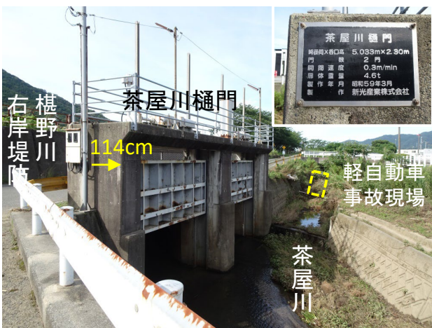
写真4.2 茶屋川樋門と軽自動車の事故現場
