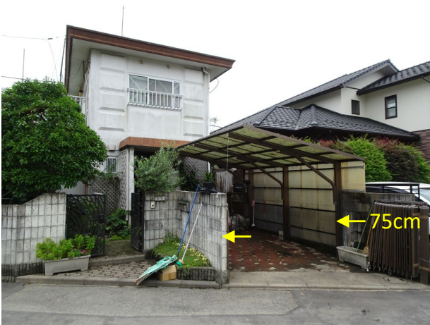
写真 1.6 田屋島における住宅の浸水被害の状況（2日撮影）
