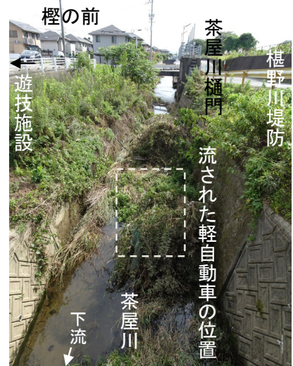
写真4.1 軽自動車が茶屋川に流された現場
