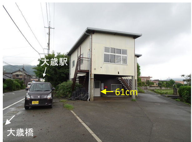
写真 2.14 朝田南自治会集会所における浸水の状況（1日 12時 59分撮影）
