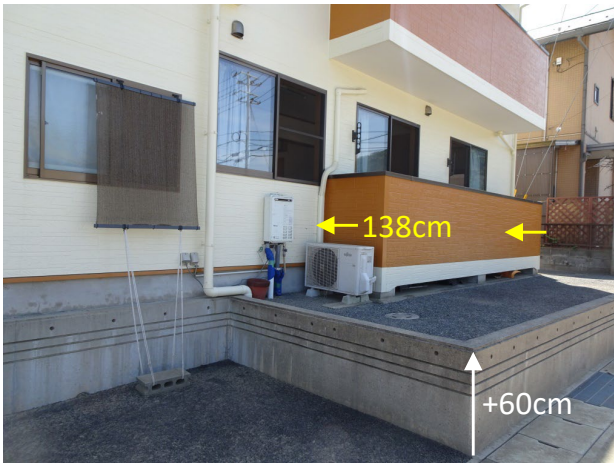
写真 4.4 店舗兼住宅における浸水痕跡
