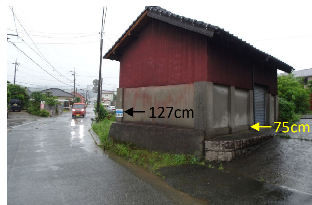
写真 2.9 岩富に設けられた 2009 年水害時の浸水実績標 (127cm) と今回の浸水深 (1日 7時 49分撮影)
