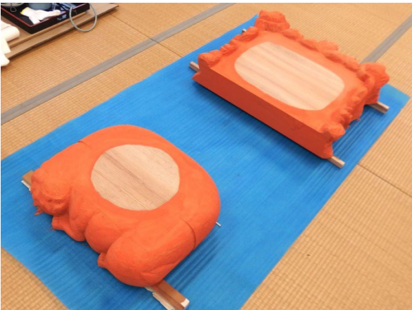
図6 ヤニ止の施工
