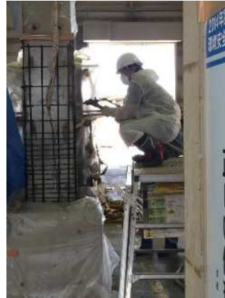
(b) 低強度 PCM 材の吹付け施工 (Case-4 供試体)
