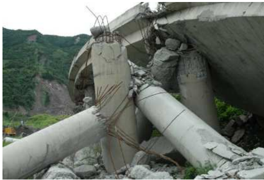
(a) 落橋部の橋脚損傷状況 (P5 橋脚)
