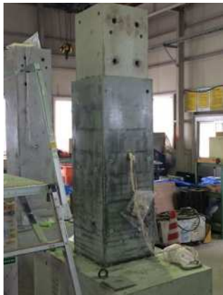
(a) 高強度 PCM 材の打ち込み施工 (Case-3 供試体)
