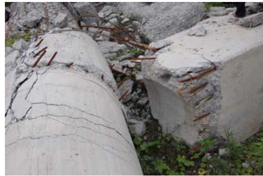
(b) 橋脚と横梁接合部の分離 (P5 橋脚)
