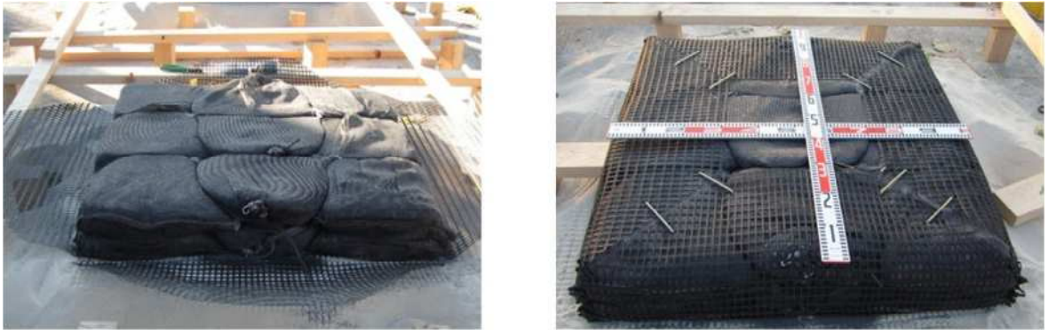
図-3.10 ジオテキスタイル土のう製作状況
