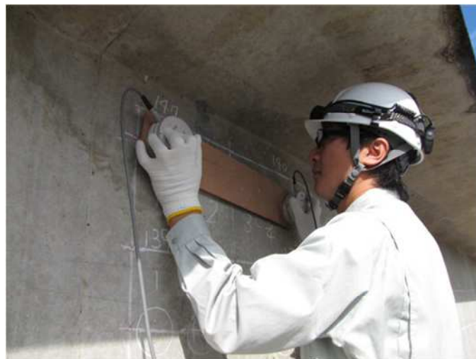
写真 4-6 WUT による PC グラウト充填調査状況
