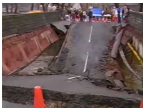
(a) Ynys-y-gwas 橋の落橋
