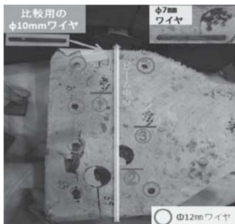
(a) 切り出し PC 部材断面写真
