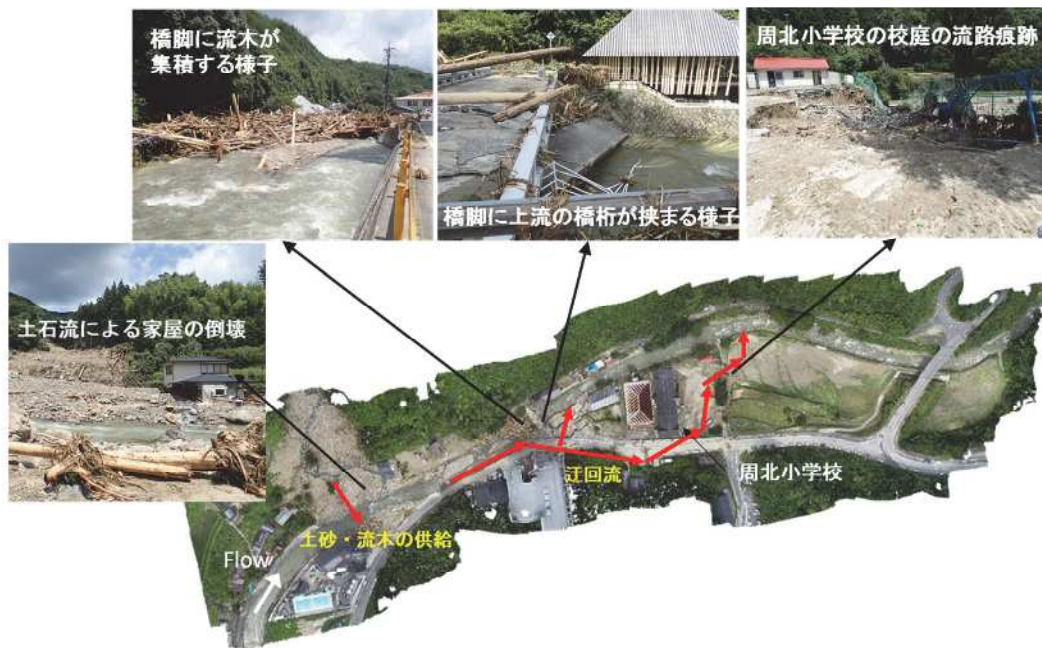
図-2.2.2 被災地周辺のオルソ画像および被災状況
