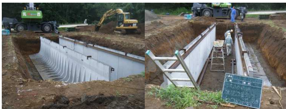
写真 3.2.1 擁壁設置状況
