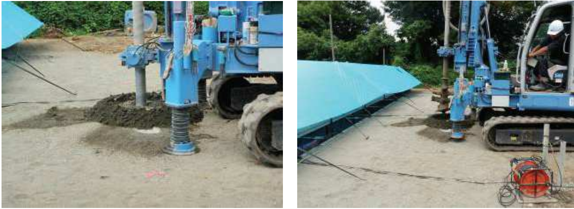
写真3.2.3 柱状改良体の施工実験状況
