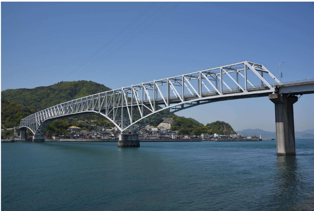
図-4.1 検討対象の鋼トラス橋
