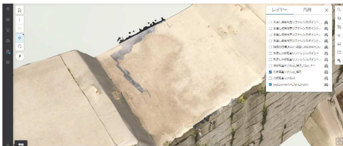
図 6-6 砂防堰堤に埋まった点検写真 3次元モデル
