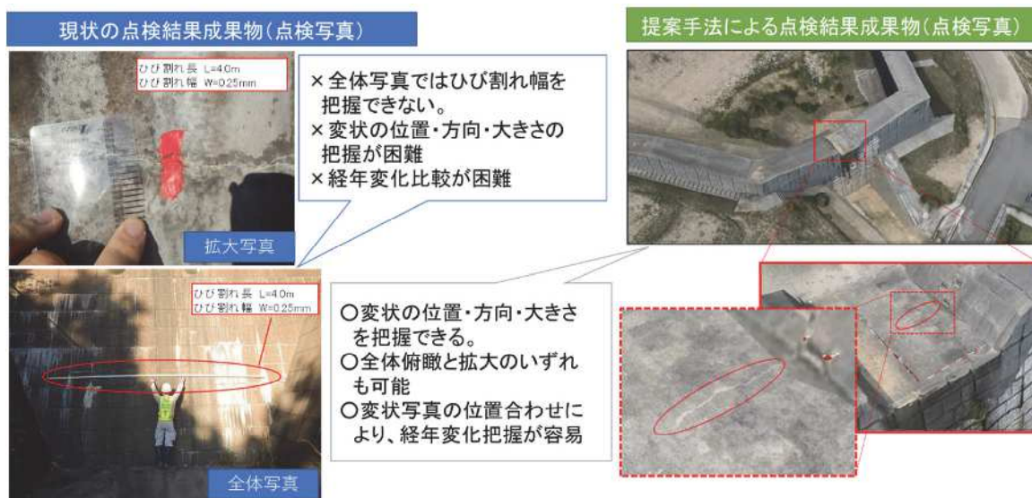
図 6-2 点検写真 (現状・提案手法)
