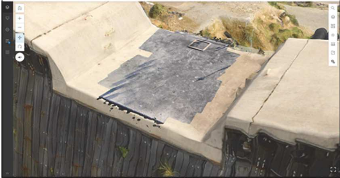
図 5-13 堰堤に貼り付けた点検写真
