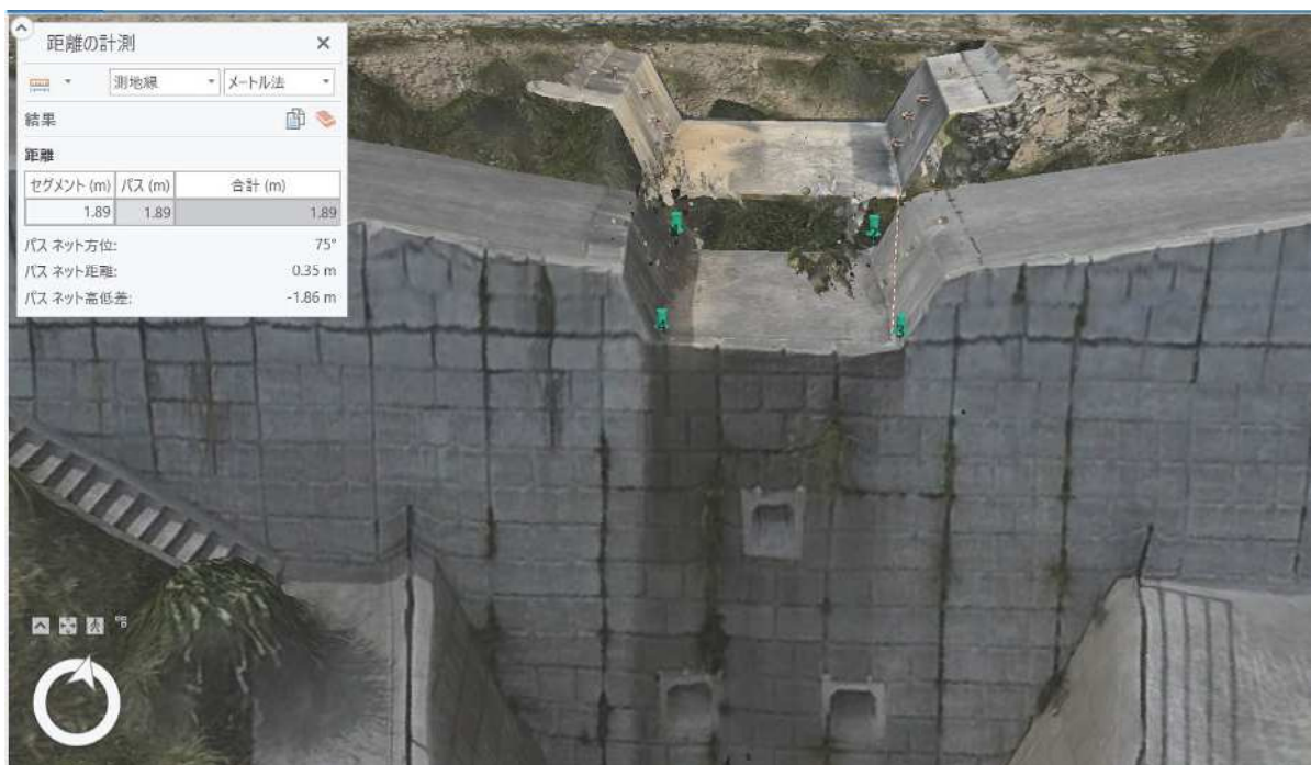
図 5-14 点検写真取り込み（改良手法）（失敗事例）
