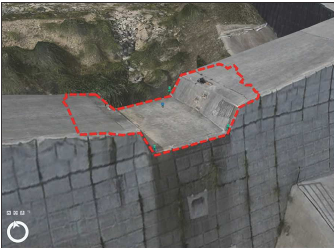
図 5-26 砂防堰堤・水通し天端 3次元モデル
