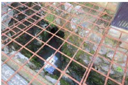
図 35 江原地区の吸い込み穴 (Mine 秋吉台ジオパーク推進協議会)
