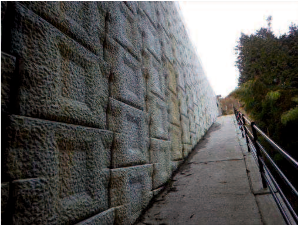
写真-1.3 アンカー補強土壁
