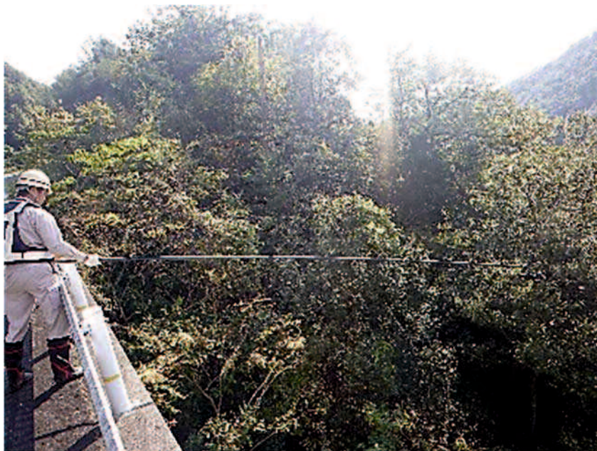
写真-2.15 ポールカメラによる壁面の確認
