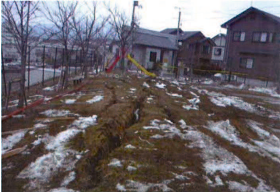
写真-2.4 被災事例① 被災箇所上面部公園施設内
