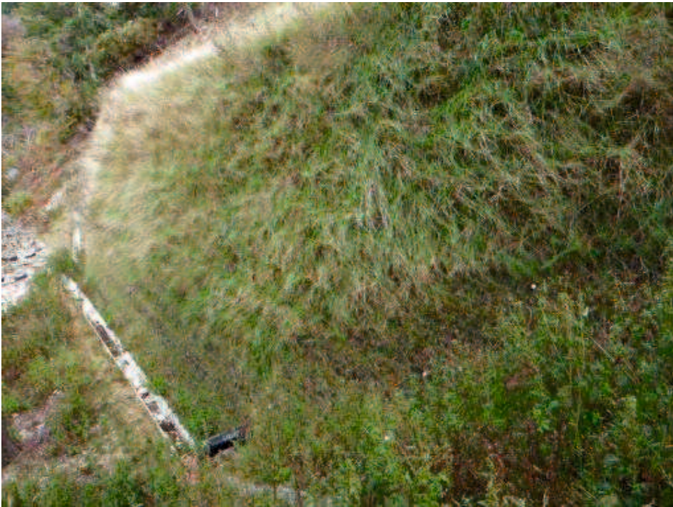
写真-1.2 ジオテキスタイル補強土壁（鋼製棒・緑化タイプ）
