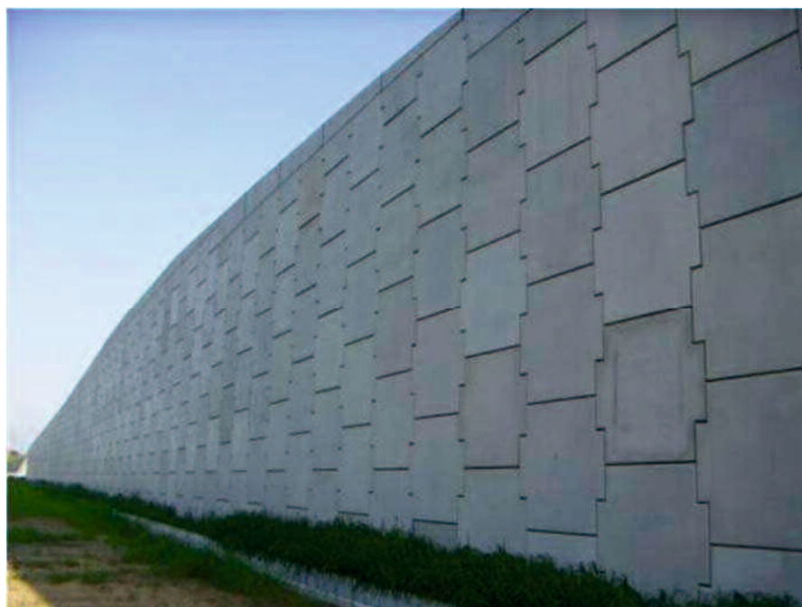
写真-1.1 帯鋼補強土壁工法
