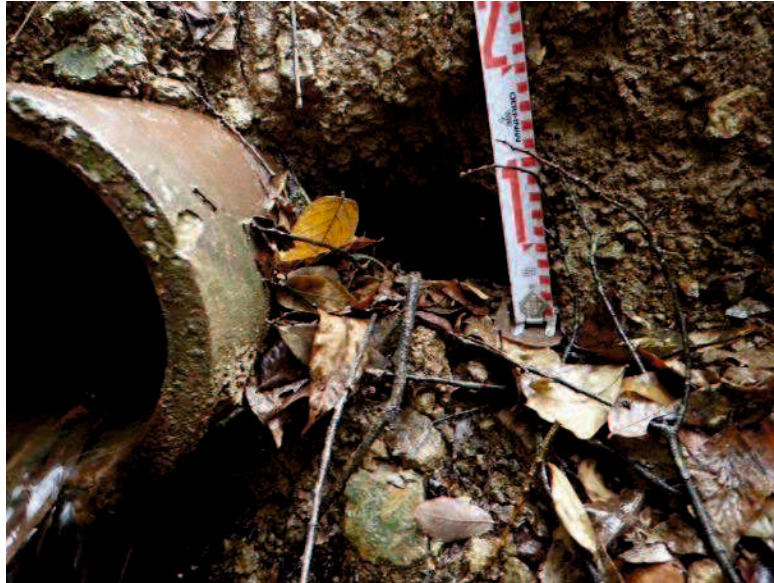
写真 1.2 底樋の脇に形成したパイピング孔 (山口県下関市船引ため池)
