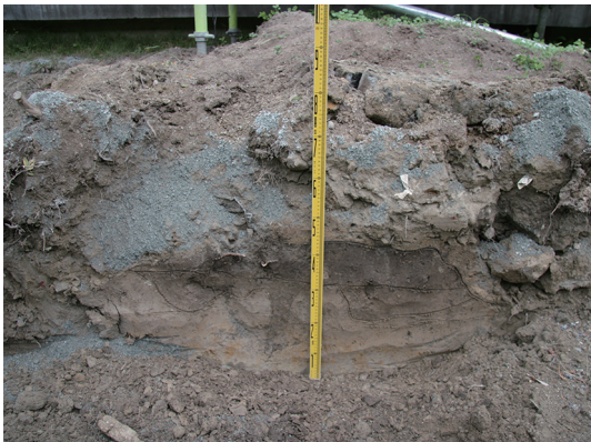
写真 101 J-3区北壁土層断面(南から)
