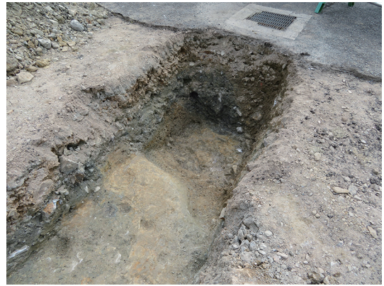
写真 74 A区河川跡完掘状況 (北東から)
