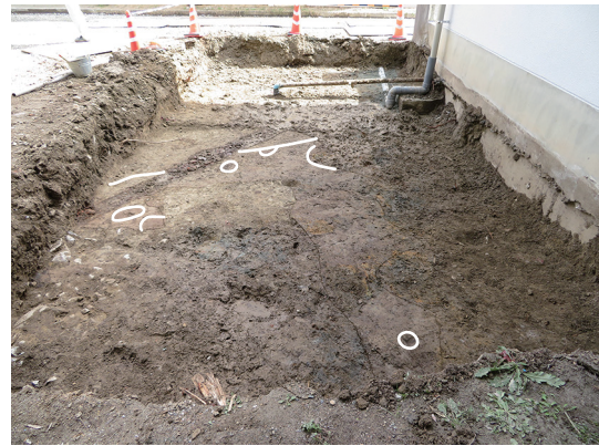
写真 143 S区遺構検出状況(北から)
