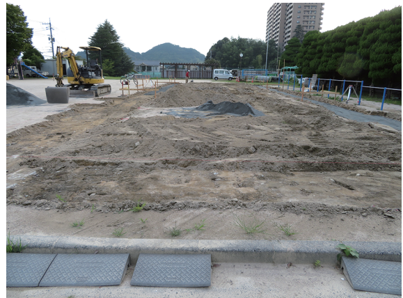
写真 155 A区掘削状況(北東から)
