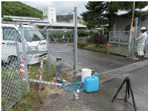
写真 157 掘削地点(南から)
