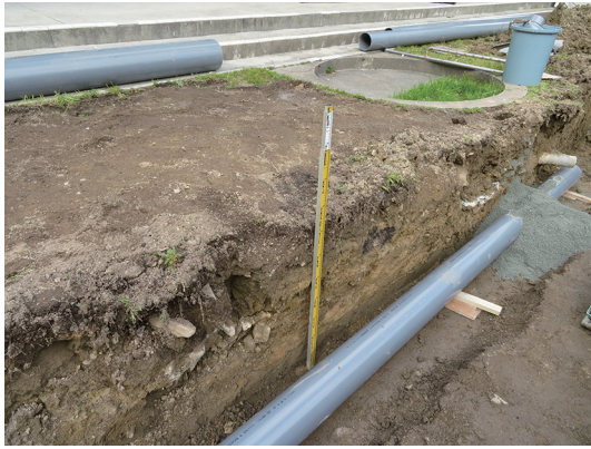
写真 150 U-5区北壁土層断面 (南西から)
