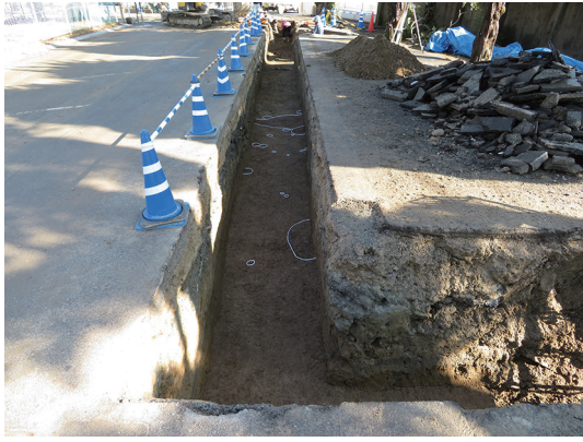
写真 123 M-2区第1面遺構検出状況 (調査区西端から10m付近まで(西から))
