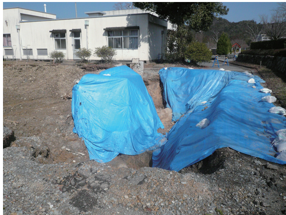
写真 51 掘削直後の状況 (南西から)
