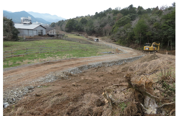
写真 34 調査地近景(北から)
