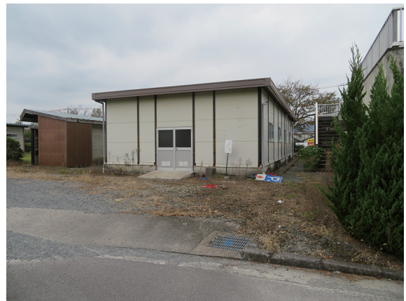
写真22 調査地近景(廃棄物倉庫撤去前)(南東から)
