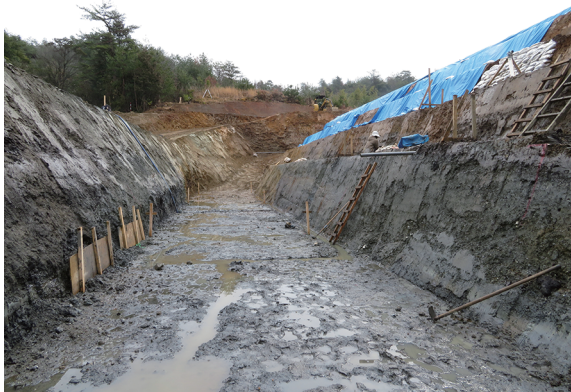
写真 45 B 地点調査風景（西から）
