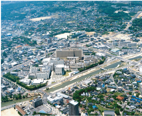
写真19 小串構内航空写真（南東から）
