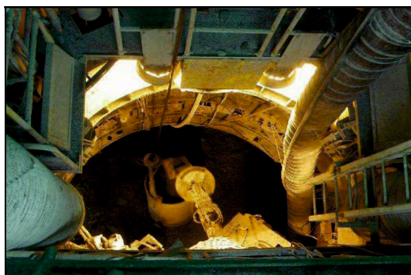
掘削土（ズリ）積込状況
