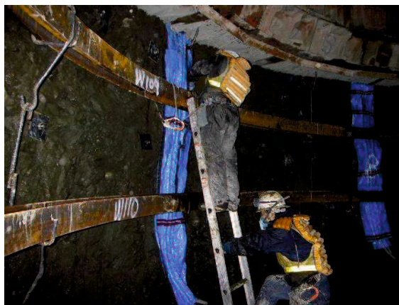
裏面排水材設置状況
