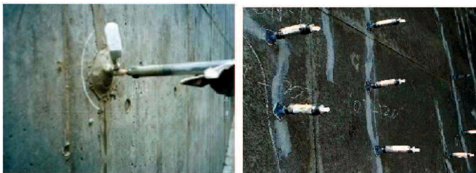
クラック注入状況
