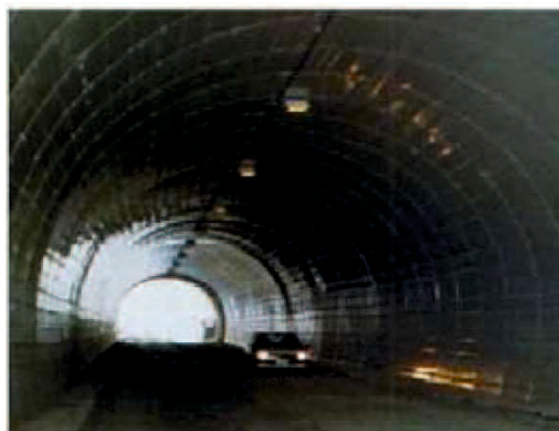
面状対策工（防水パネル工）
