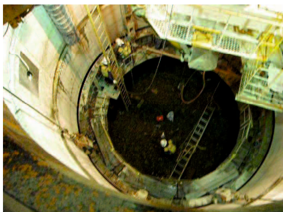
移動式型枠設置況
