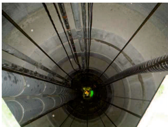
覆工完了状況
