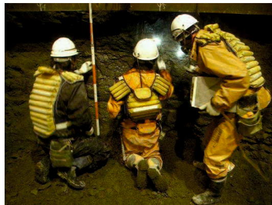
壁面観察状況
