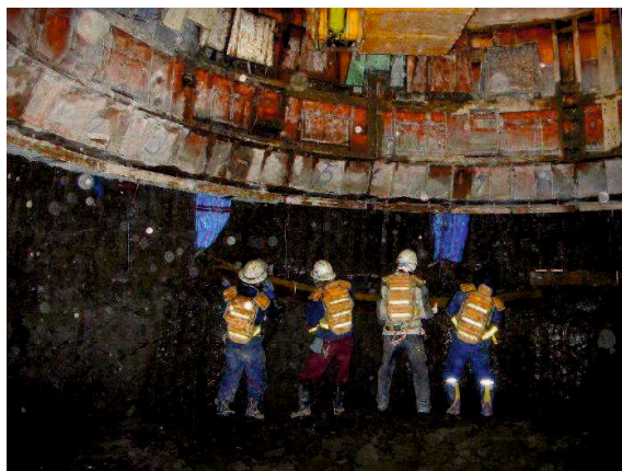
鋼製支保工設置況
