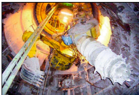
掘削機・積込機全景
