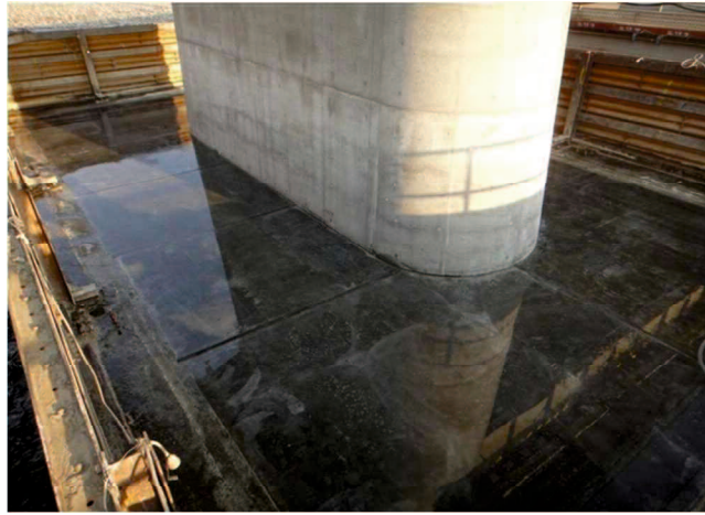
写真-6.3.9 養生完了時の状況
