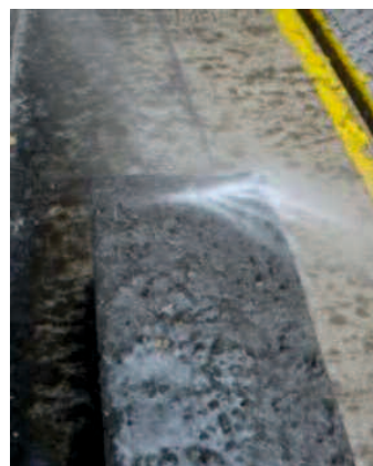
写真-6.4.1 目粗し作業の状況
