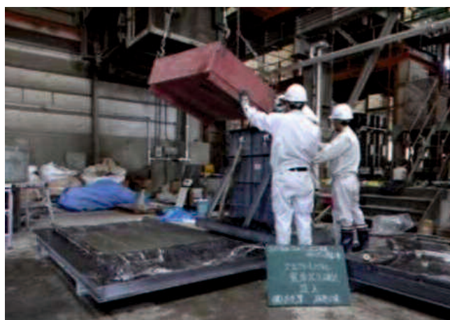
写真-6.4.4 打込み状況
