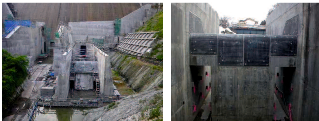
写真-6.4.8 パネルの設置状況
