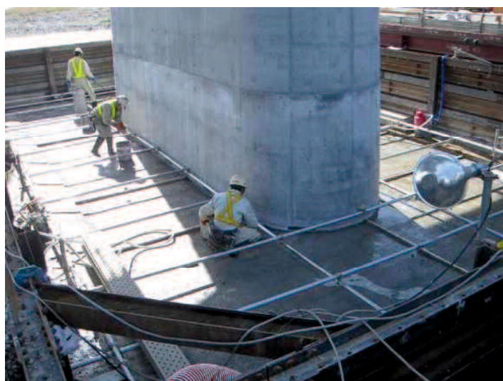
写真-6.3.6 UFC の施工場所
