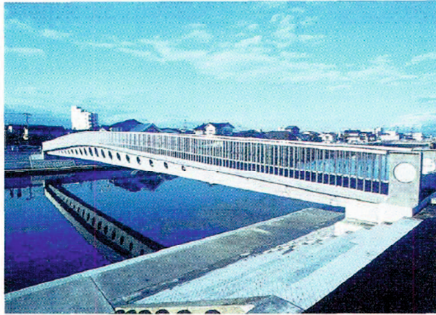
写真-2.7.1 酒田みらい橋
