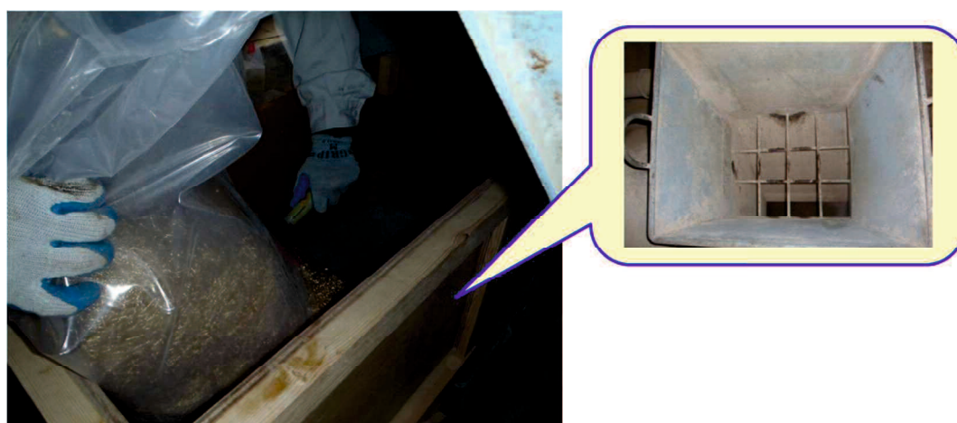
写真-5.4.1 鋼繊維投入場の外観
