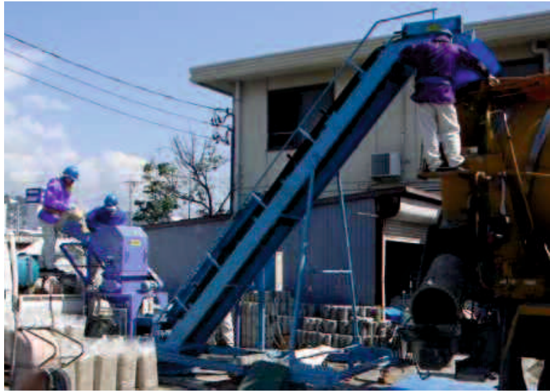
写真-5.6.1 鋼繊維の投入状況
