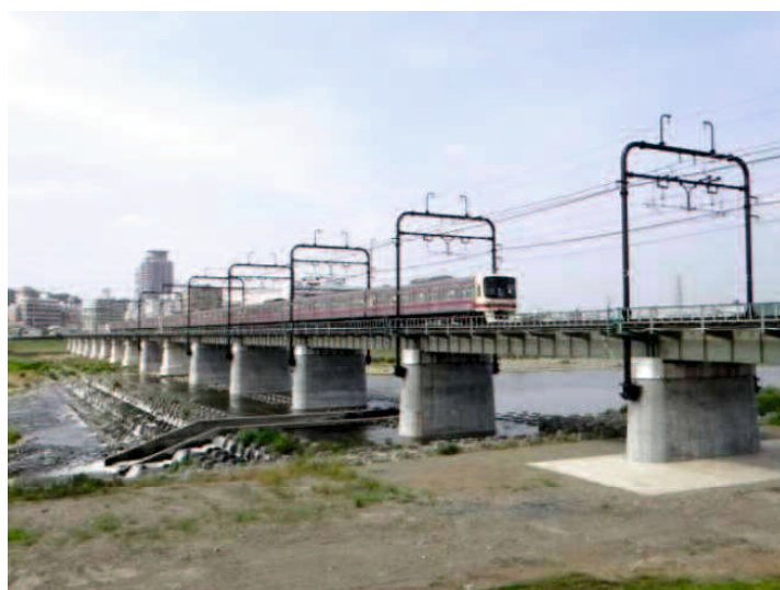
写真-6.3.1 UFC を適用した橋梁
