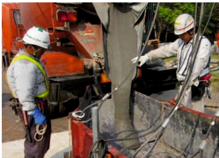
写真-6.2.2 トラックアジテータからの荷卸し状況
