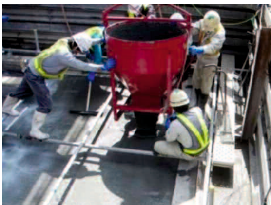
写真-6.3.7 打込み状況
