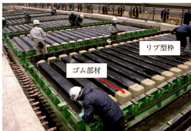
写真-2.7.2 UFC 床版の型枠設置状況 〔武者ら[2010]〕
