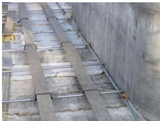
写真-6.3.8 散水養生の状況
