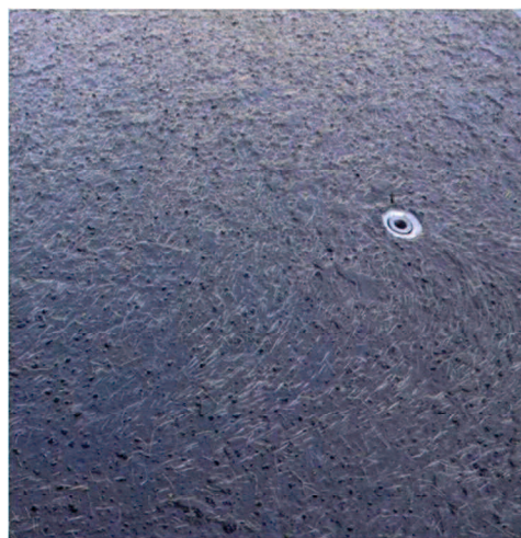
写真-6.4.6 目粗し後のパネル表面
