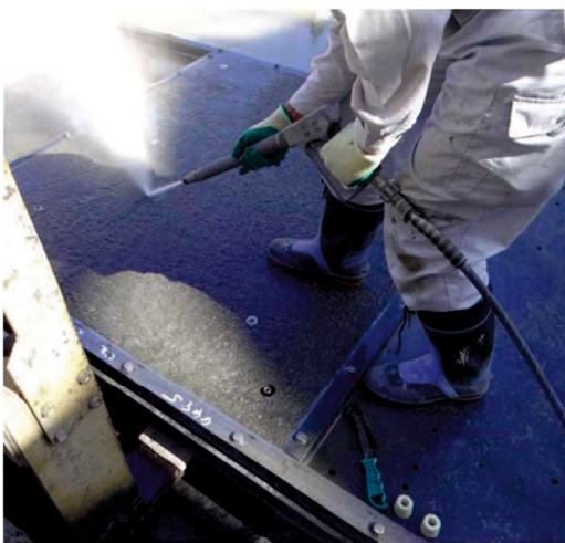
写真-6.4.5 目粗し作業の状況
