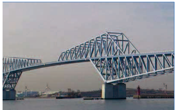
写真-2.1 東京ゲートブリッジ 18)
