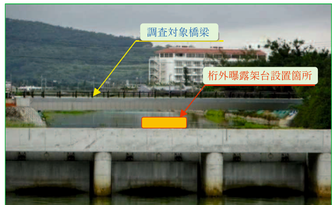
写真-3.8 桁外曝露架台位置
