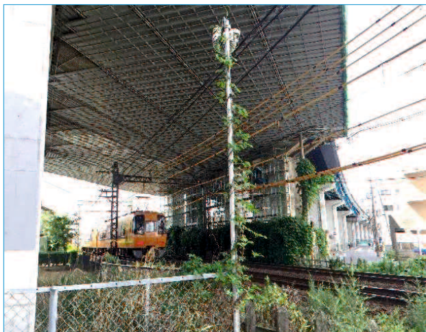
写真-5.4 塗装用仮設足場（外観）
