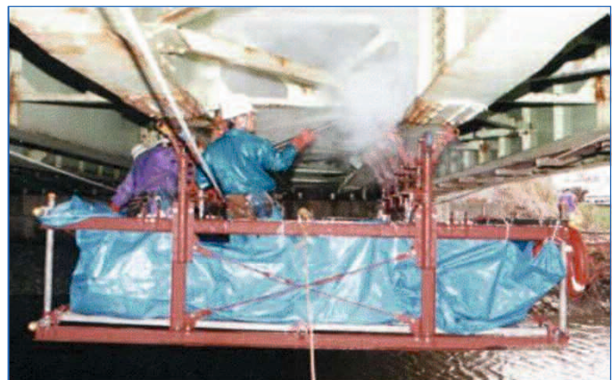
写真-2.3 簡易移動吊足場を用いた洗浄状況 32)
