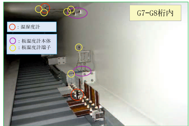
写真-4.1 桁内配置状況
