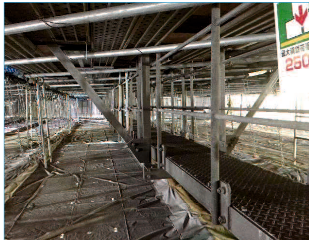
写真-5.5 塗装用仮設足場（内部）
