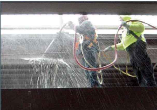
写真-2.2 ニューヨーク州橋梁公団洗浄作業 32)
