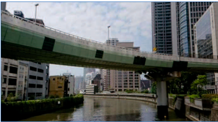
写真-2.4 都市内高速の化粧板設置状況
