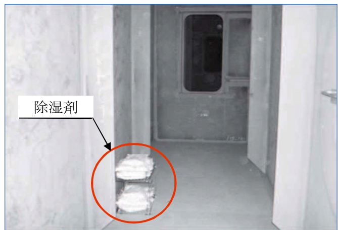
写真-2.10 箱桁内への設置状況 51)
