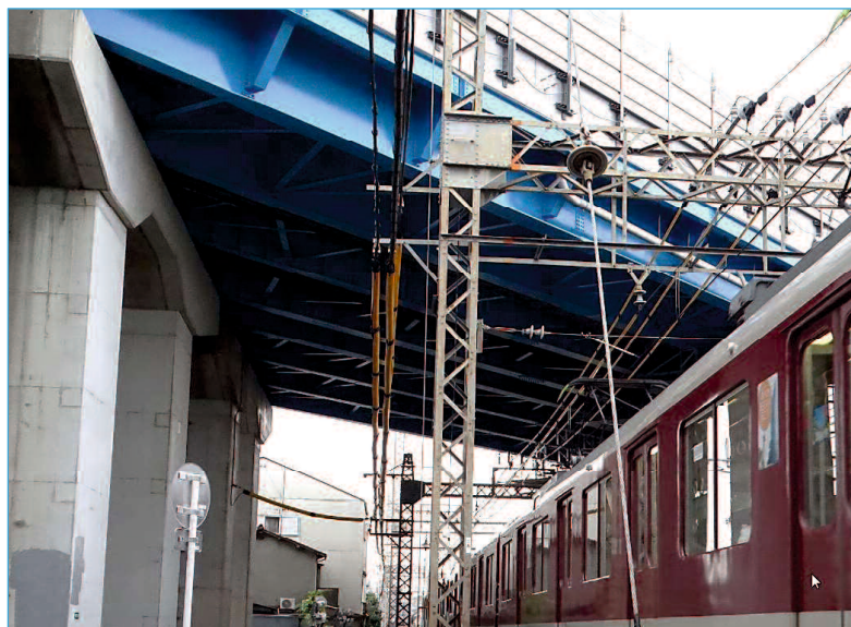
写真-5.3 高架橋 (跨線橋) 全景
