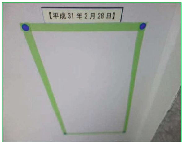
写真-3.19 桁端部（2019年2月） 〈再結露なし〉
