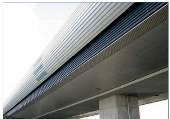
写真-2.5 裏面吸音板の設置状況
