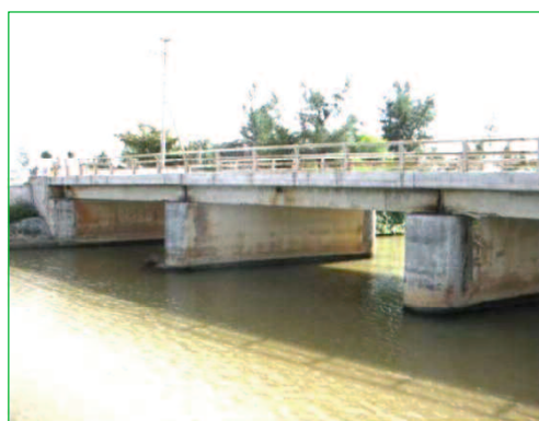
写真-3.10 旧橋全景（コンクリートT桁橋）
