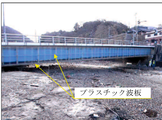
写真-2.6 塩囲いによる防護状況 39)
