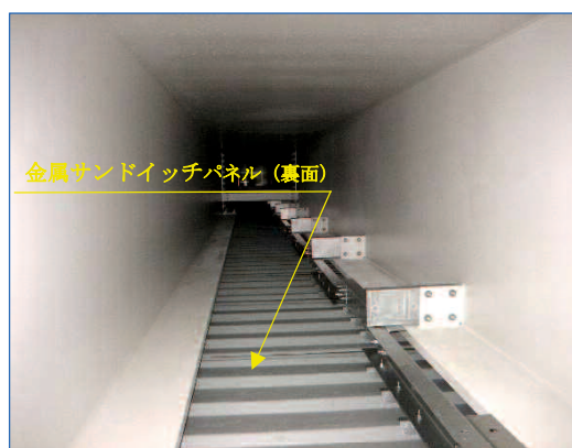
写真-5.2 金属パネル（桁内部）
