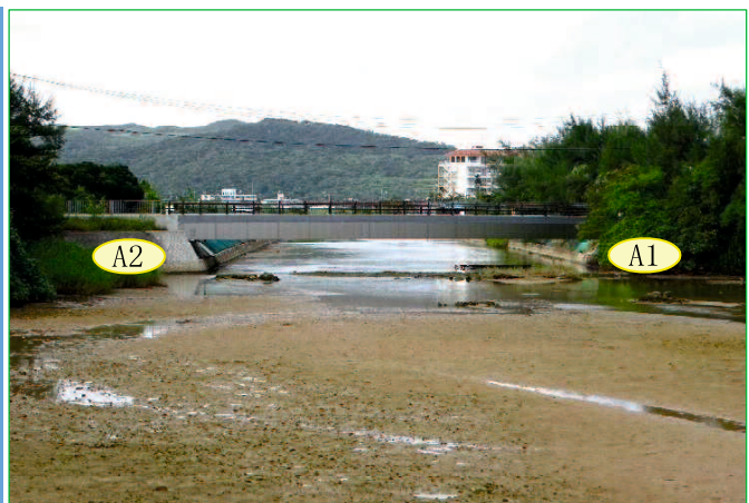
写真-3.15 架橋周辺状況（海側から撮影）
