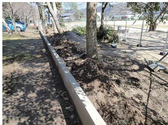
写真 245 調査区全景 (南西から)
