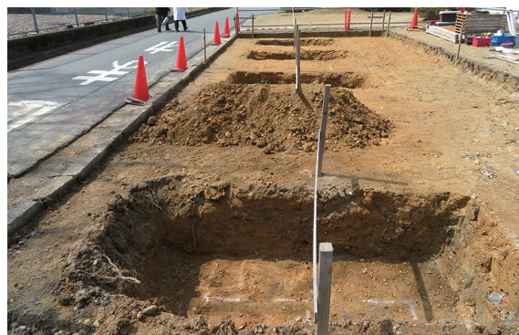
写真 229 調査区全景 (東から)
