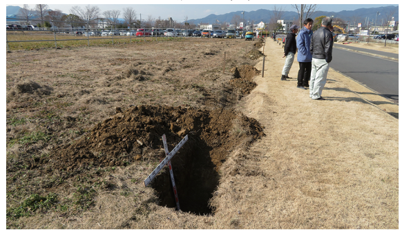
写真 237 桜植え替え掘削全景(東から)
