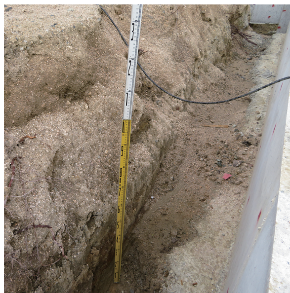
写真 217 A区の工事掘削状況 (西から)
