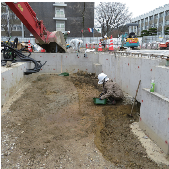
写真 218 B区南調査区作業風景 (西から)
