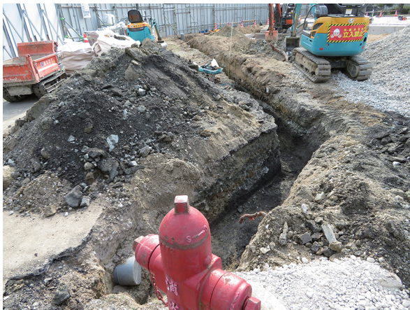
写真 224 配管掘削ルート (北東から)
