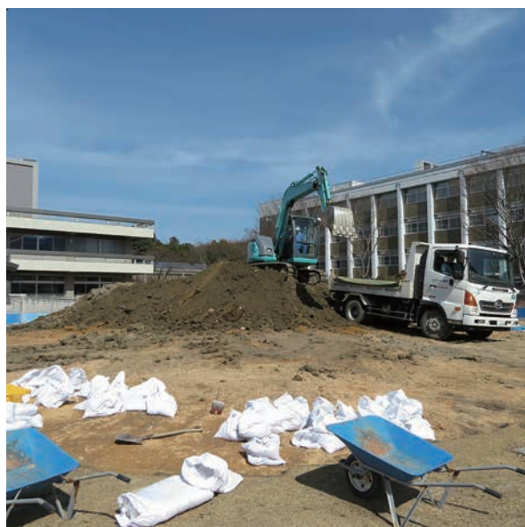
写真 50 予備発掘調査残土排出作業(南西から)
