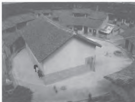
写真5 土楼内観(完成後)
