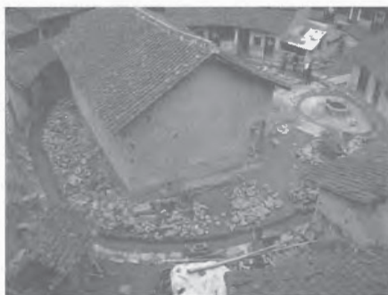
写真4 土楼内観(工事中)
