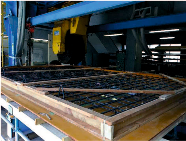
(a) 鉄筋型枠組立完了
