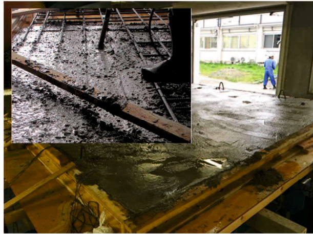
(b) ベースコンクリート打設
