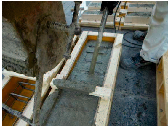
(a) ベースコンクリート打設
