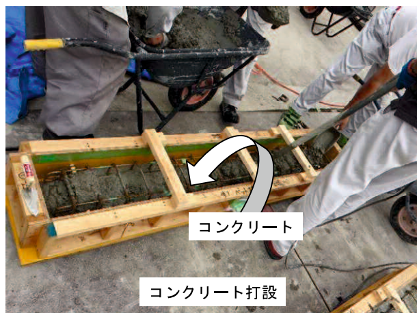
(a) ベースコンクリート打設
