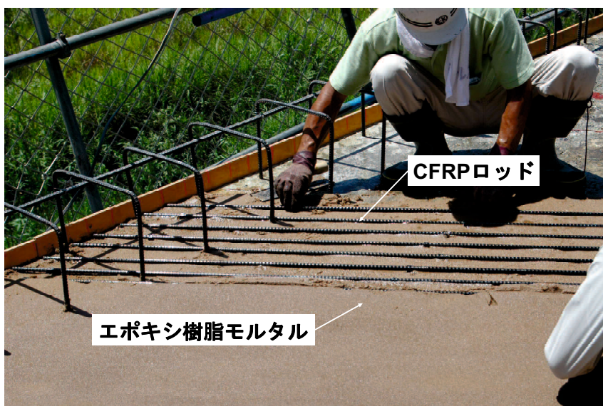
図 1-10 CFRP ロッドにて NSM 補強を行った施工例
