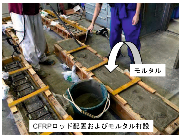
(c) CFRP ロッド配置 モルタル打設
