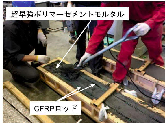
(d) 超早強ポリマーセメントモルタル打設
