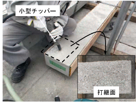
(b) 表層かぶりコンクリート除去
