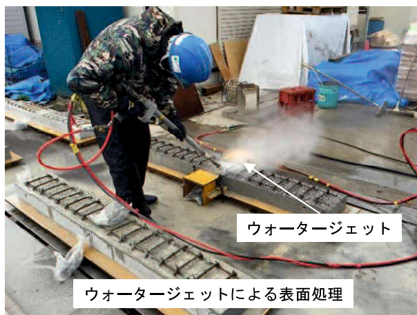
(b) 打継面下地処理 (Water-Jet)
