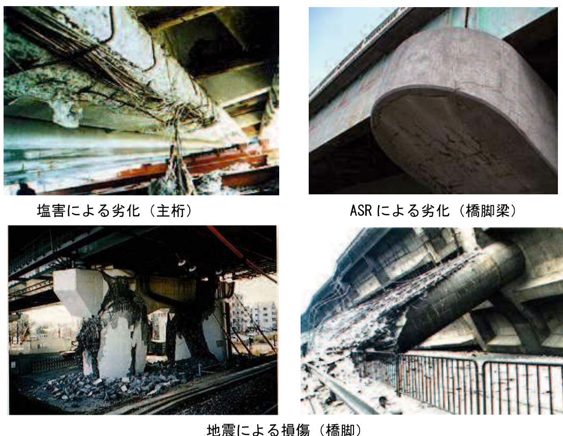
図-1.1.2 コンクリート構造物の劣化・損傷事例 〔土木研究所 構造物メンテナンスセンター，2020〕
