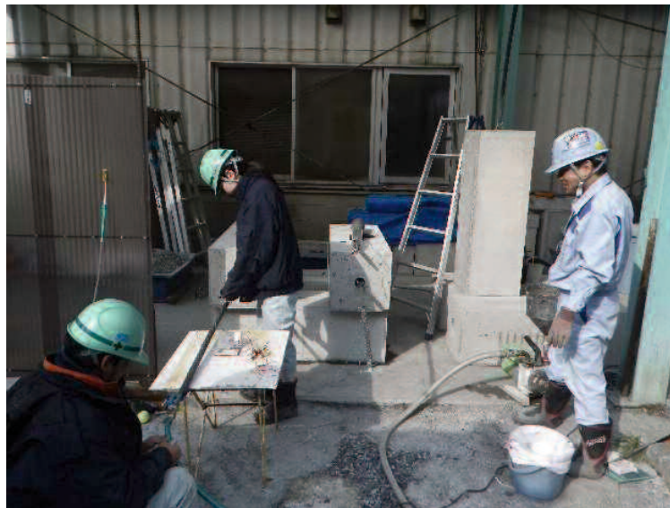
図-3.6.1 グラウト材の注入（水平方向）
