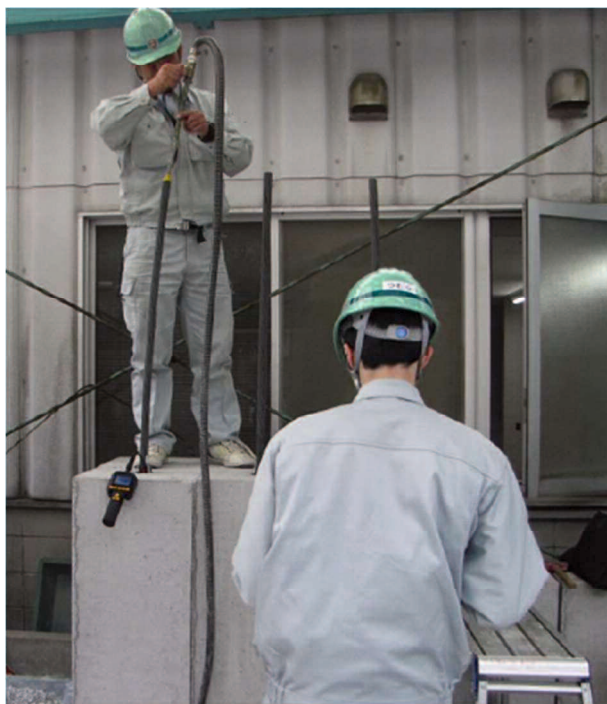
(d) グラウト材の充填作業（鉛直方向）
