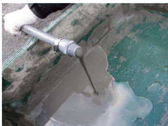
図-3.3.3 グラウト材の排出
