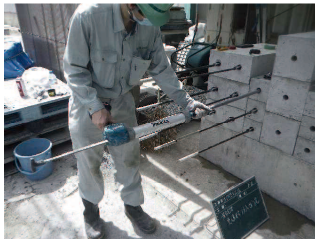
(d) 緊張材の定着作業（水平方向）
