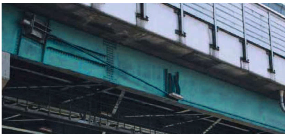
図-1.1.5 鋼桁への適用事例
