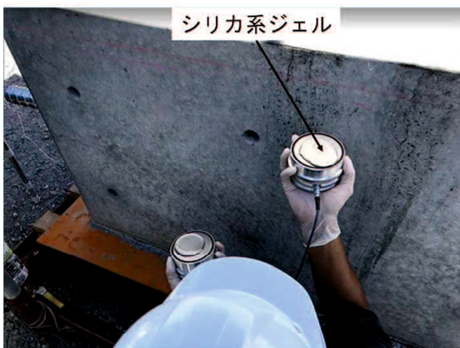
図-4.2 接触媒質の塗布状況
