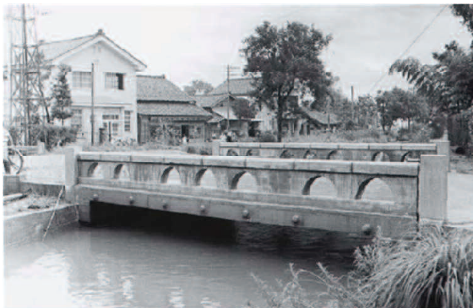
図-1.5 昭和 28 年 6 月に撮影された十郷橋 3)
