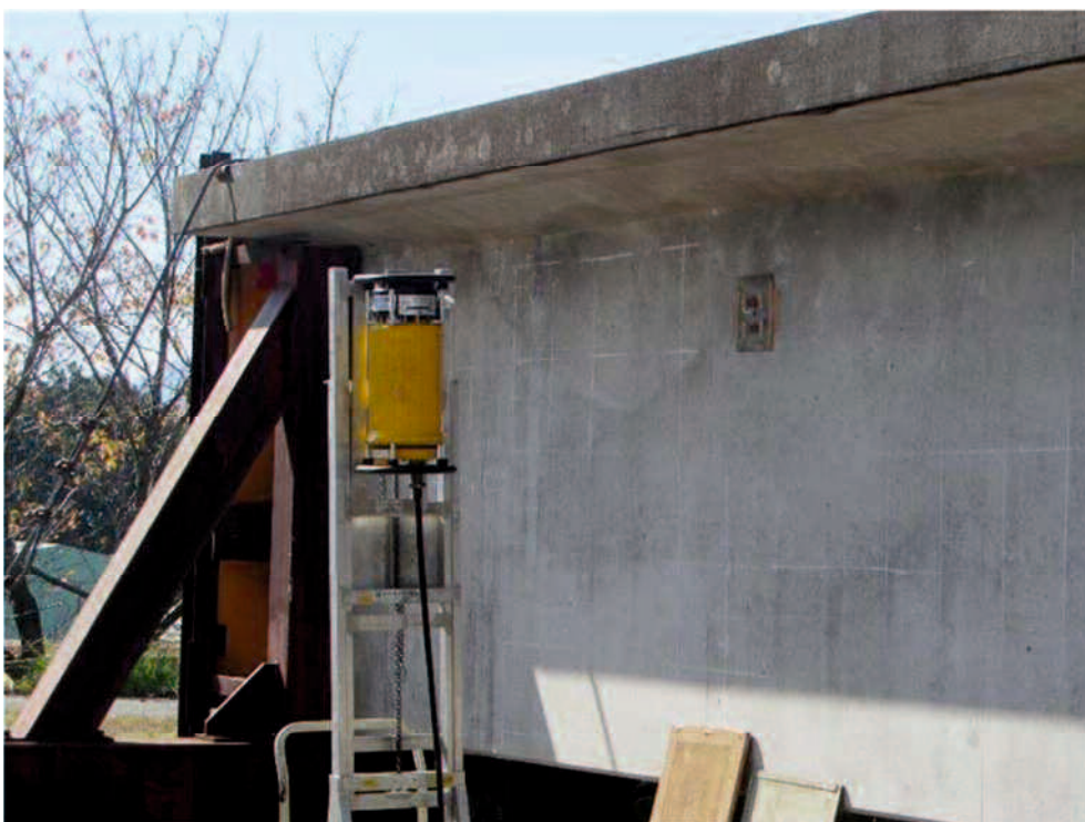
図-3.27 XRT による PC グラウト充填調査概況
