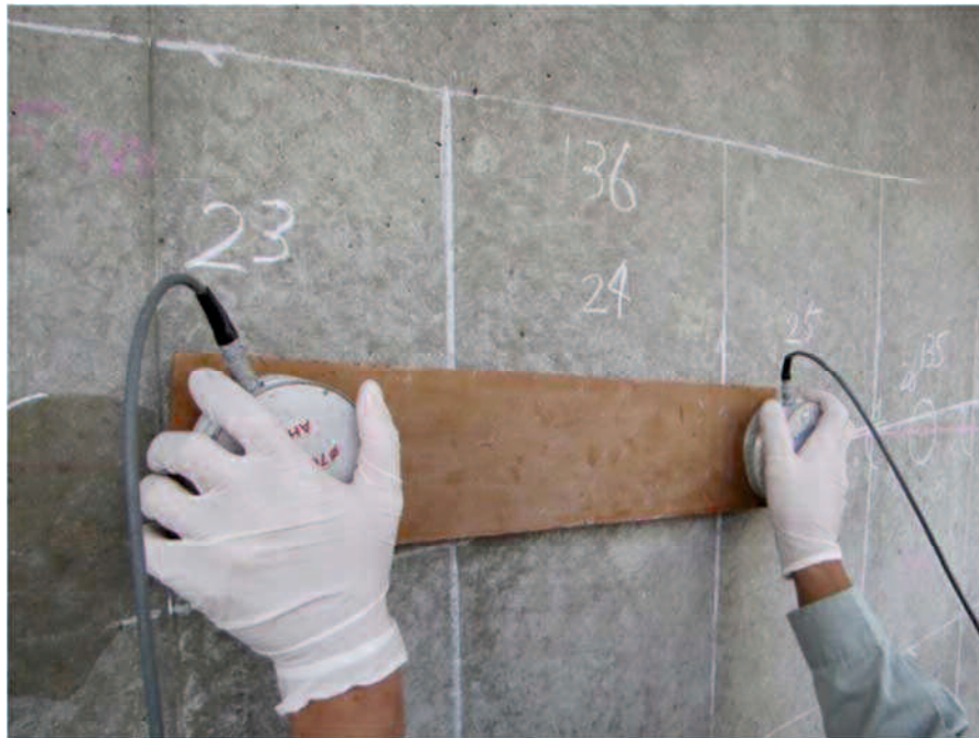
図-3.7 WUT を用いたグラウト調査状況
