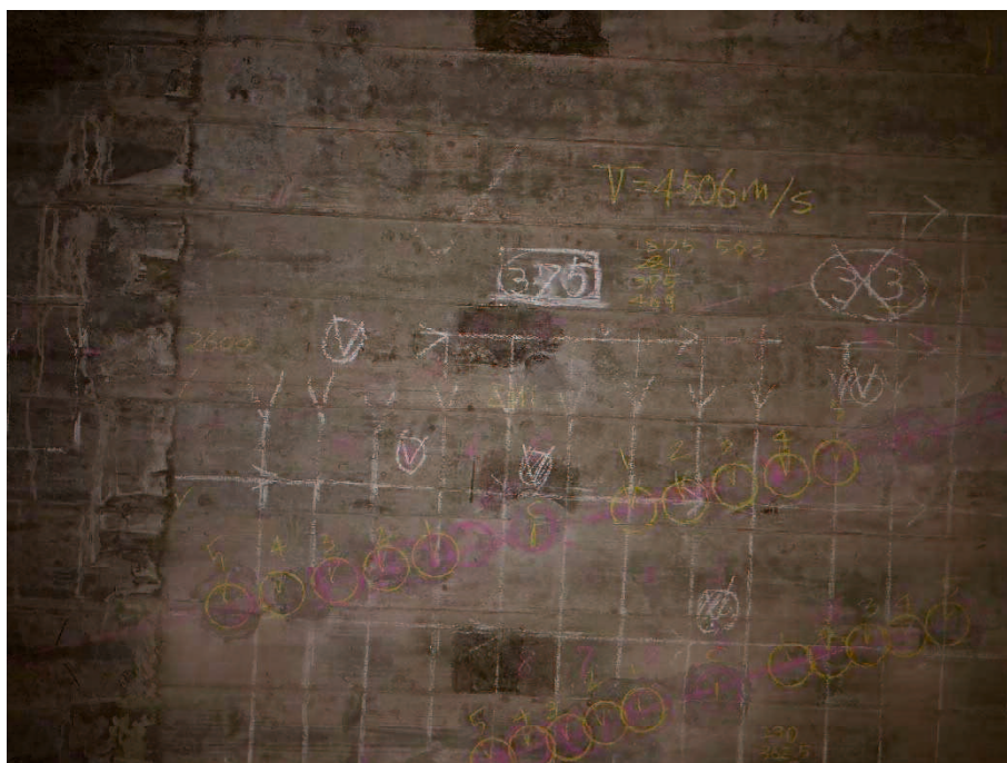
図-5.11 鉄筋とPC鋼材の位置出し状況（ケーブル番号 526）
