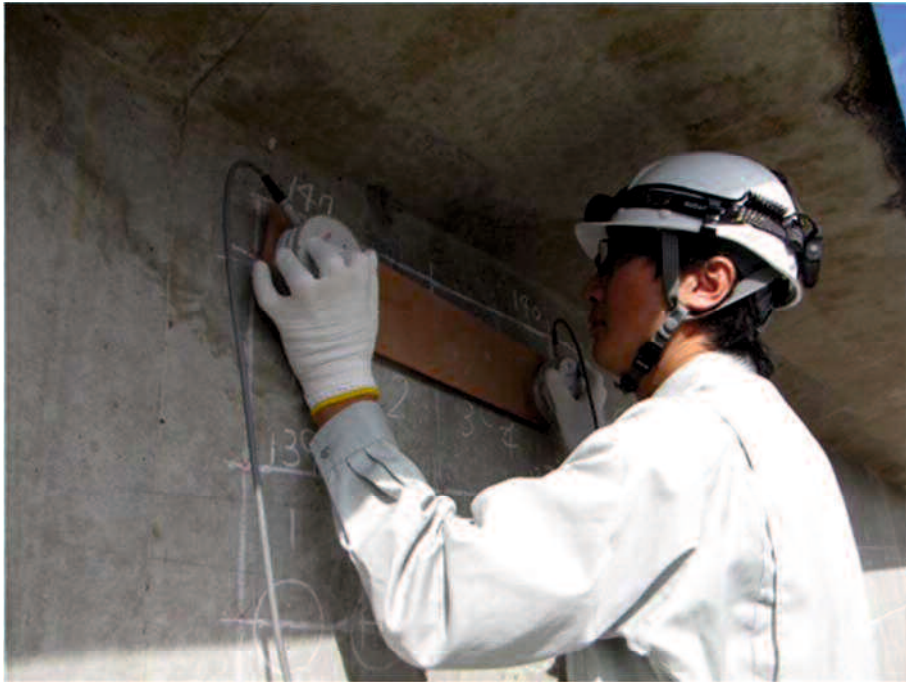
図-3.31 WUTによるPCグラウト充填調査状況
