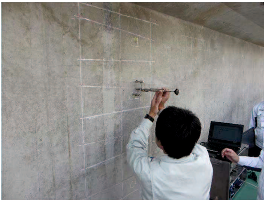
b) 鋼球の設置状況
