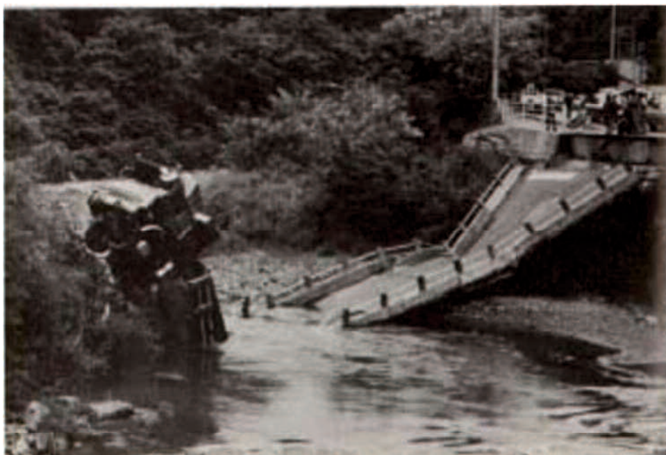
図-1.17 新管橋の落橋 13)
